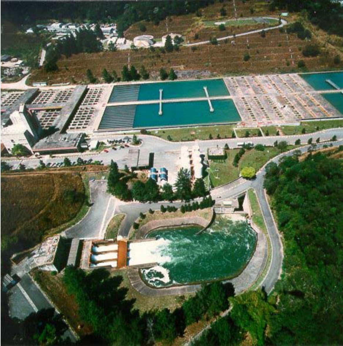
Vista da ETA Guaraú
