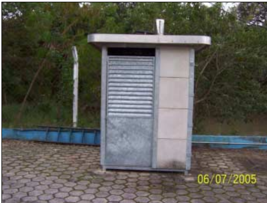
Figura 3.53 - Posto Captação Valinhos
