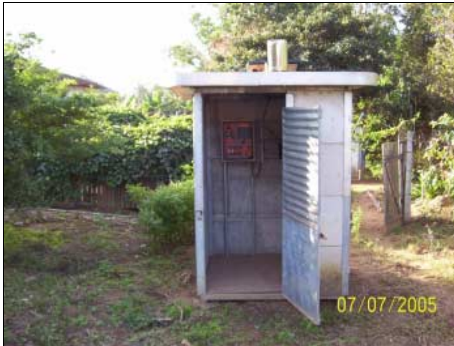
Figura 3.48 - Abrigo do Posto Bairro da Ponte
