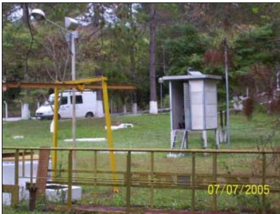
Figura 3.33 - Posto Captação Piracaia
