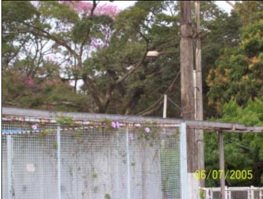
Figura 3.8 - Cabo de Sinal do Sensor de Nível
