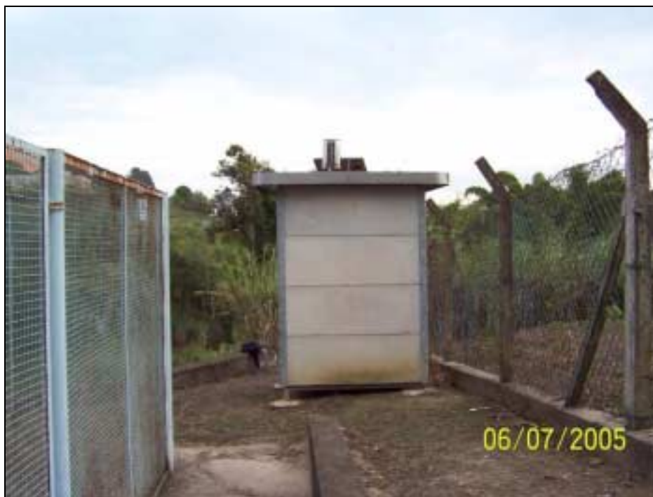
Figura 3.6 - Abrigo do Posto Carioba
