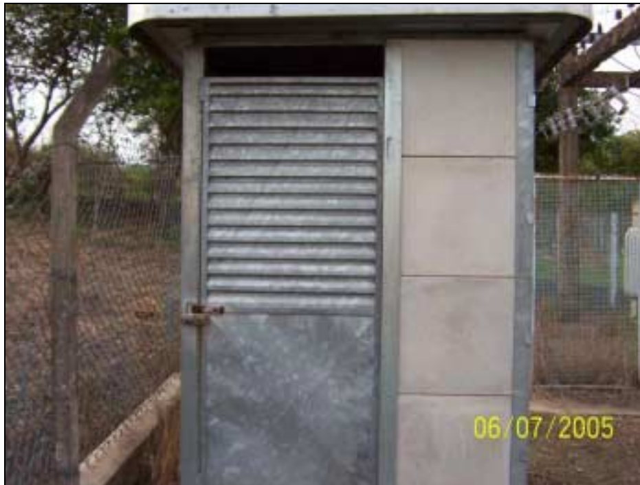
Figura 3.5 - Abrigo do Posto Carioba
