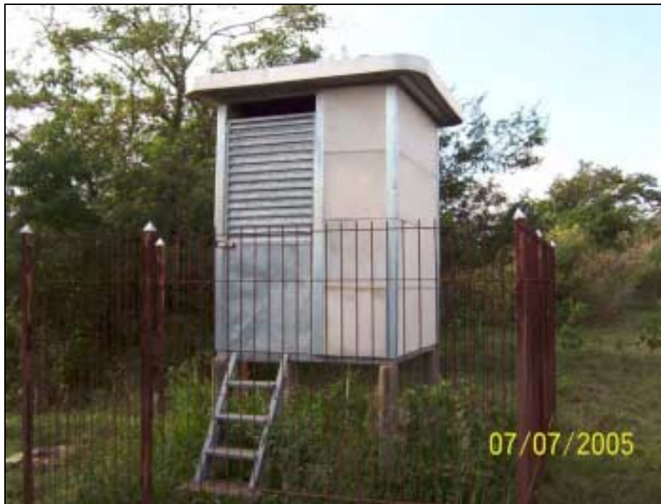
Figura 3.19 – Abrigo do Posto Dal'Bo
