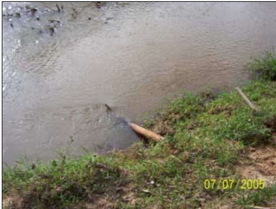
Figura 3.22 - Duto do Sensor de Nível do Posto Dal'Bo
