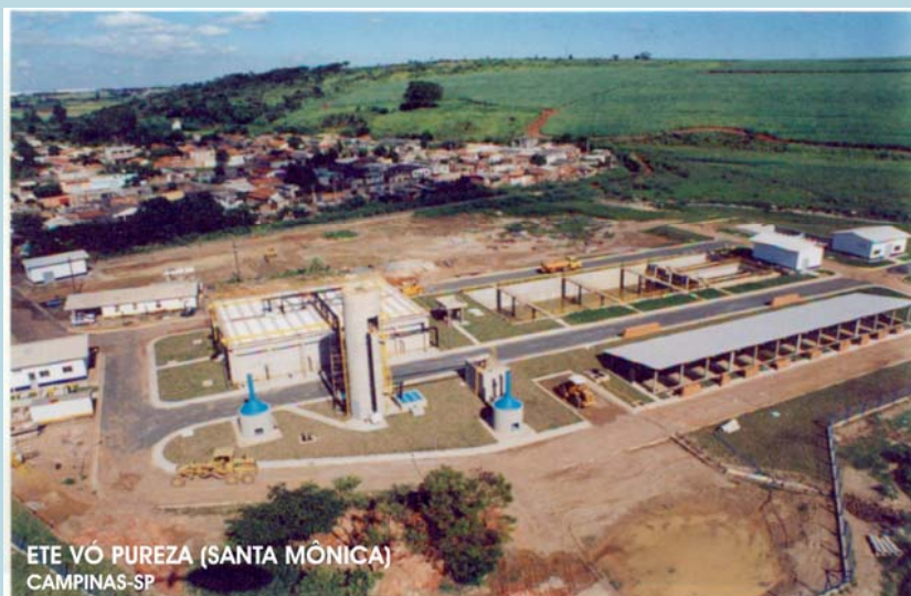
ETE VÓ PUREZA UASB + Lodos ativados
