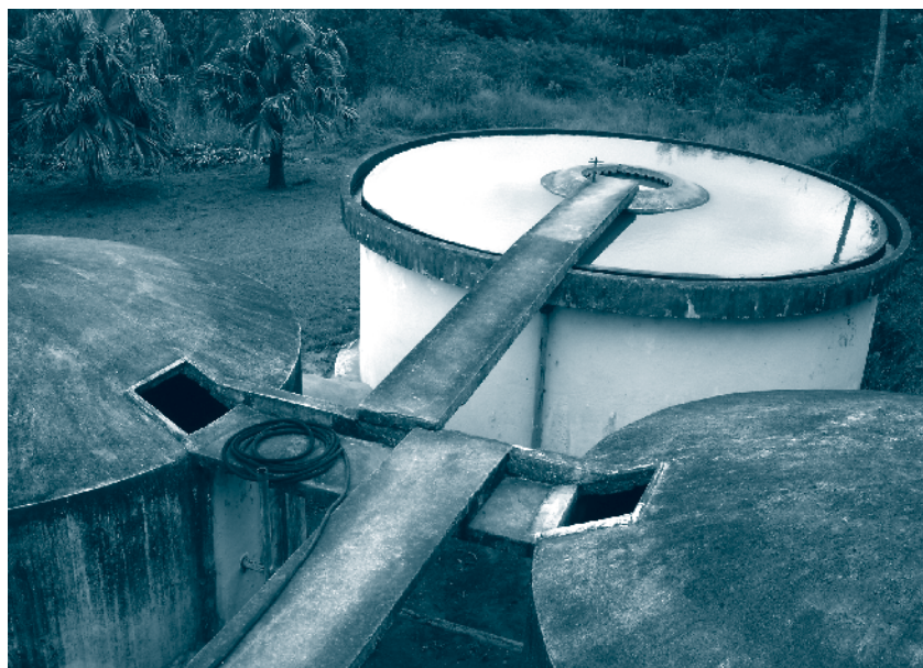
Figura 2.28 – Floculador de bandejas ao centro de um decantador circular de fluxo radial, dois filtros rápidos em paralelo, de difícil acesso para operação e manutenção, ETA de pequeno porte, antiga, com operação e manutenção precárias
