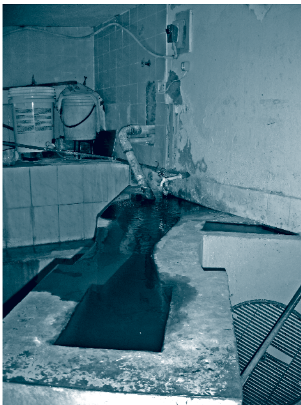
Figura 2.19 – Exemplo de unidade inadequada de mistura rápida (calha Parshall): instalações e controle precários da mistura rápida e coagulação
