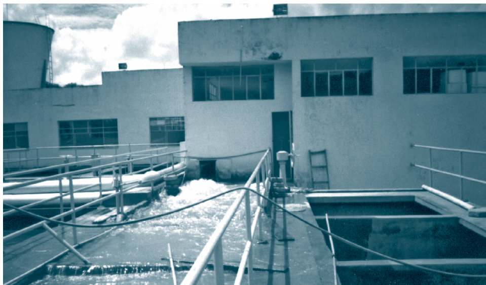
Figura 2.22 – Exemplo de unidade com funcionamento inadequado de floculador: excesso de vazão e transbordamento nas câmaras de floculação
