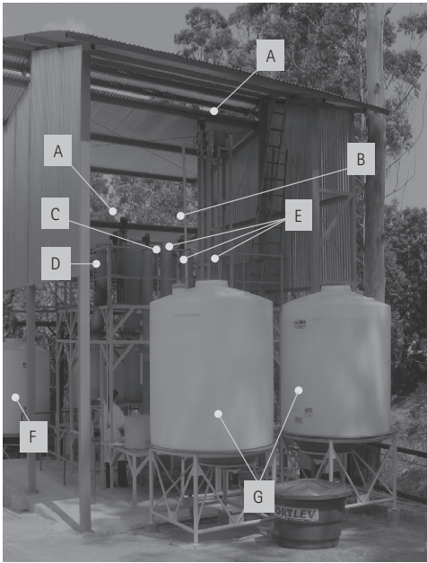
Figura 4.6 Vista geral da ETA Piloto Copasa/UFMG: (a) mistura rápida, (b) floculadores, (c) decantador de baixa taxa com escoamento vertical, (d) decantador de alta taxa, (e) filtros, (f) tanque de preparo da água de estudo, (g) tanques de água tratada
