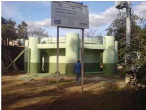
Estação de tratamento de água convencional
