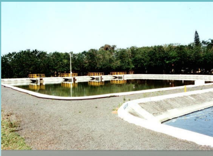
Lagoas de Aeração e Decantação
