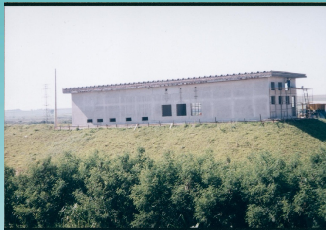
Cabine primária, casa dos geradores e sala de operação e controle
