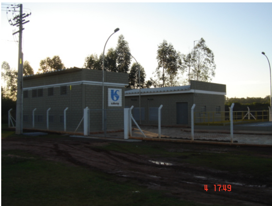
Foto 1 – Estação Elevatória de Esgotos Final.
