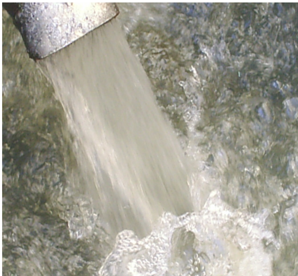
Entrada de água de reuso na calha Parshall
