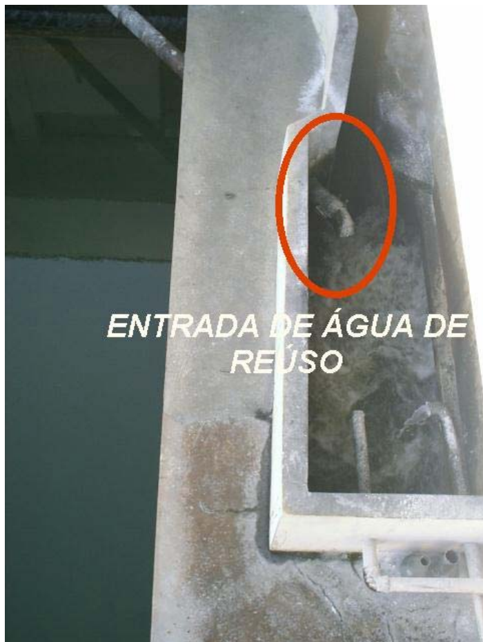
Entrada de água de reuso na calha Parshall
