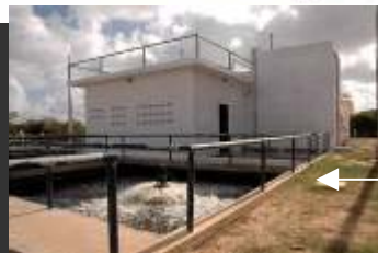
Estação de Tratamento de Efluentes
