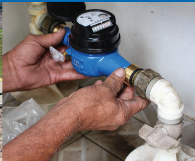
Instalação de hidrômetros (Salto) - Foto: Josevane Victor
