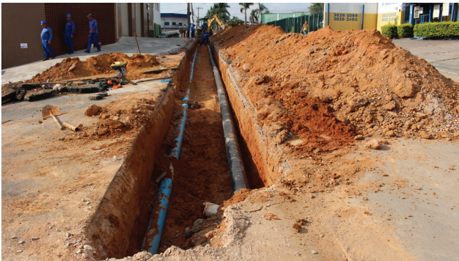
Substituição de rede de água (Vinhedo) - Foto: Josevane Victor
