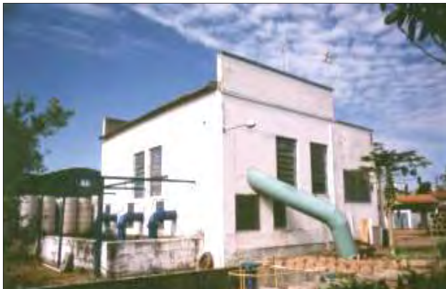
Foto 6: Sistema de captação no Rio Atibaia
