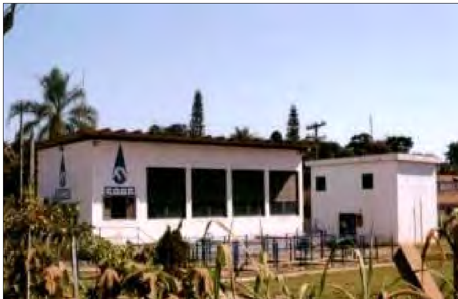
Foto 7: Sistema de captação do Córrego Onofre
