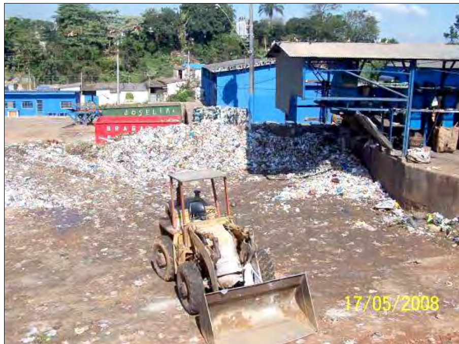
Foto 10: Central de triagem de resíduos sólidos
