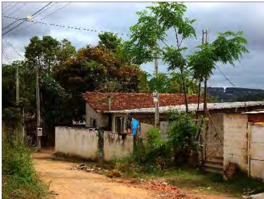
Foto 19: Vias no bairro Guaxinduva, sem pavimento
