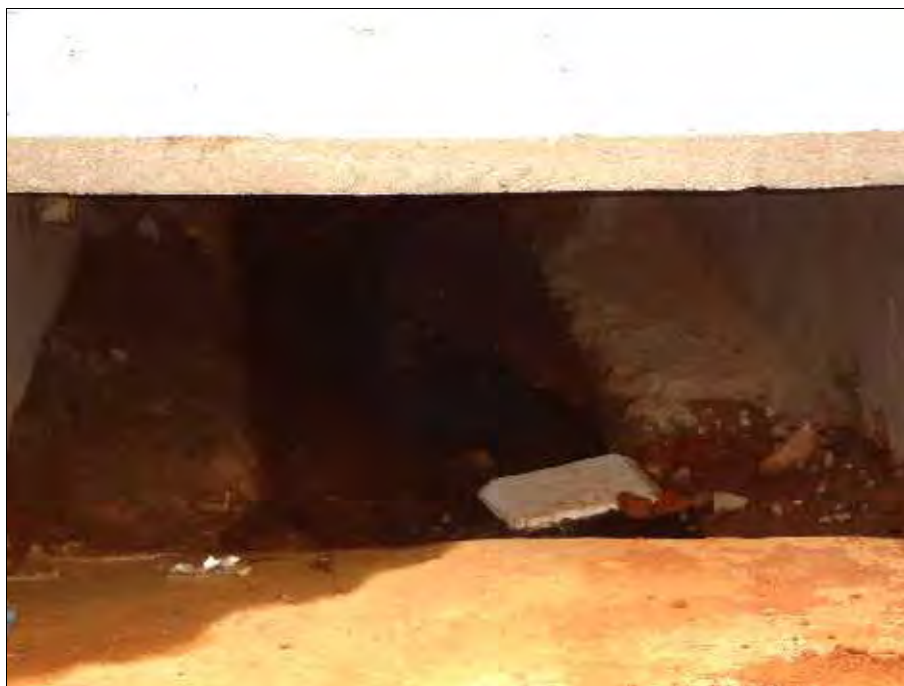
Foto 24: Jardim Kanimar – esgoto e águas pluviais numa só canaleta
