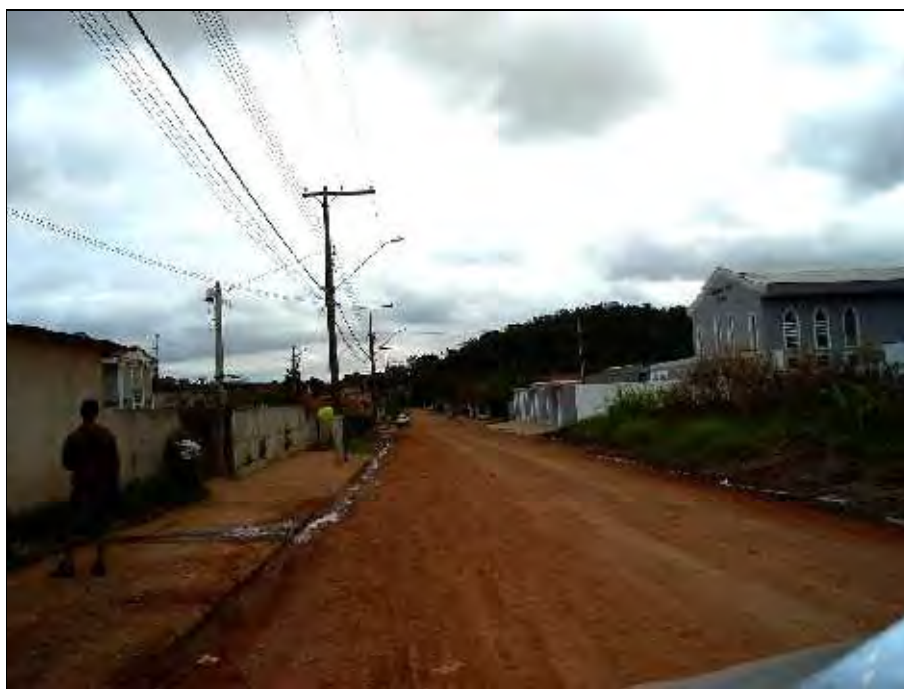
Foto 22: Jardim Kanimar – vias sem asfalto
