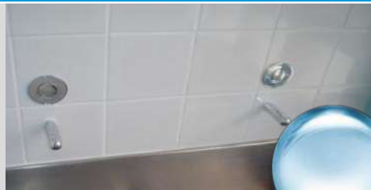
Torneiras com fechamento automático anti vandalismo após as intervenções
