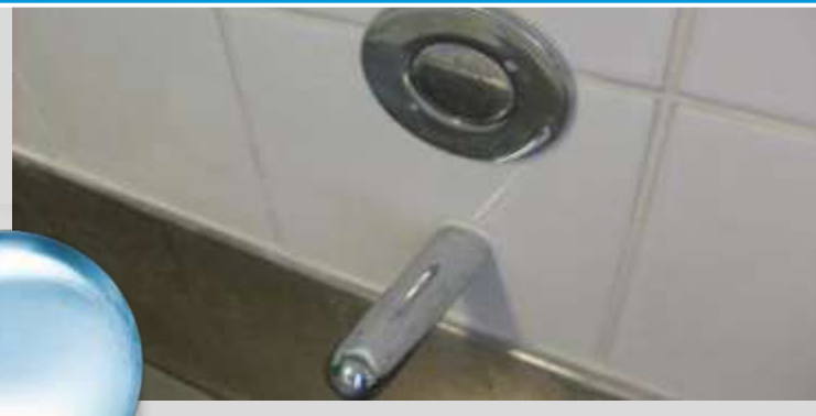
Torneiras com fechamento automático anti vandalismo após as intervenções
