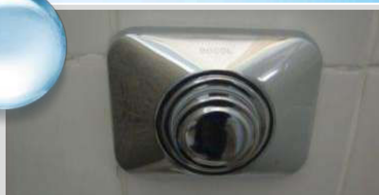
Torneiras com fechamento automático anti vandalismo após as intervenções
