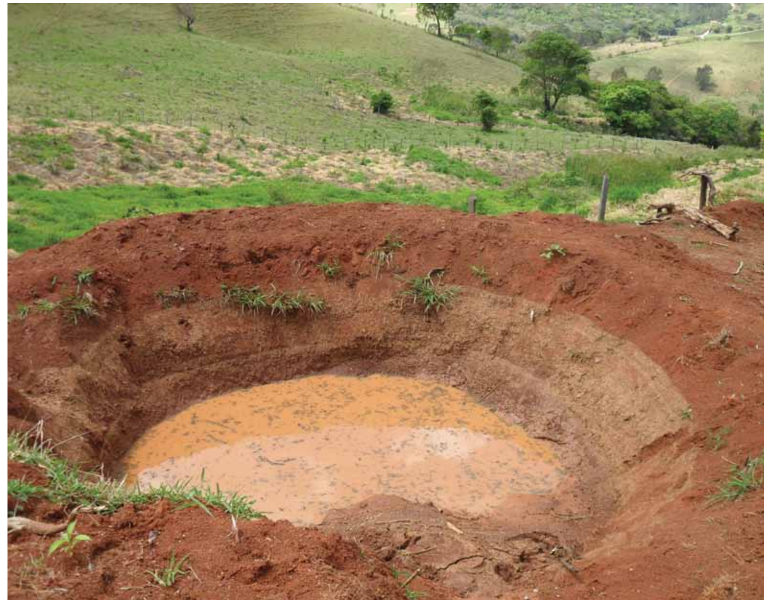
Fotos 94, 95 e 96 - Bacias de contenção - Bairro das Posses
