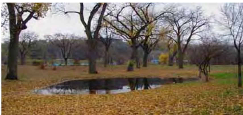
Figura 5.5 – Bacia de infiltração
