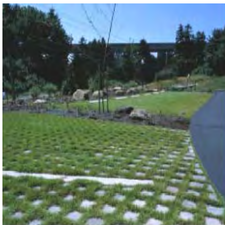
Figura 5.6 – Estacionamento de pavimento modular
