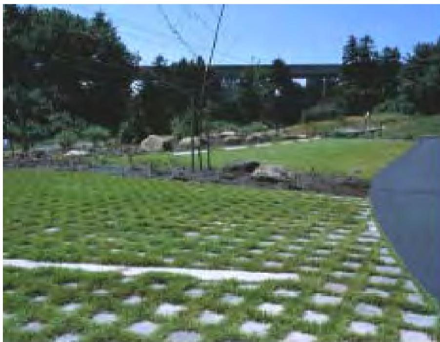
**Figura 2.4.3.2-1: Exemplo de estacionamento com pavimento modular**
