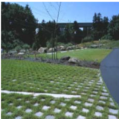
Figura 5.6 – Estacionamento de pavimento modular
