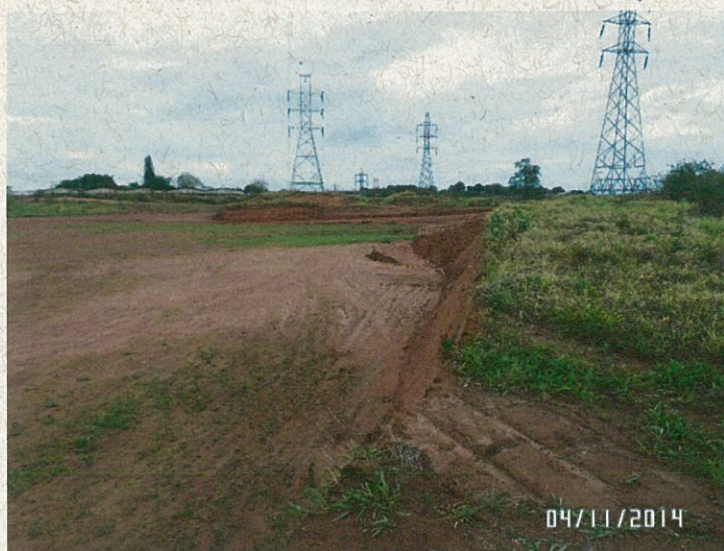
Foto 7. Vista dos taludes onde será realizada a semeadura de grama.
