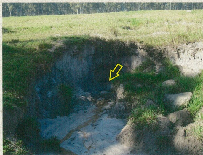
FOTO 06 - Detalhe da cabeceira do sulco erosivo mostrando a erosão interna regressiva (piping) na porção basal decorrente da exposição do nível freático pela remoção da camada de solo.
