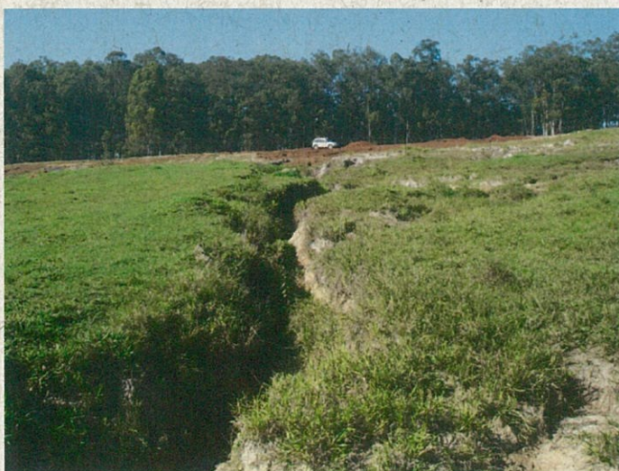
FOTO 05 - Erosão linear ativa desenvolvida perpendicularmente ao caimento da encosta.
