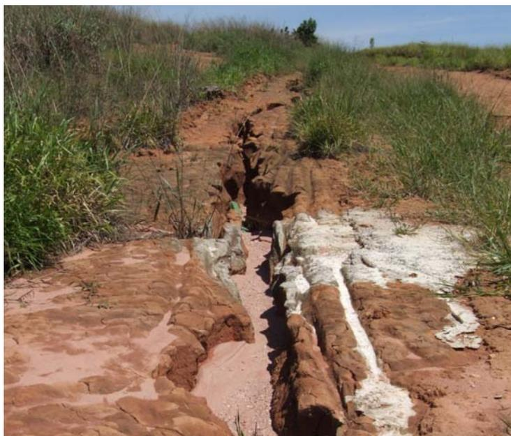
Foto 2 - Visada de Este em acesso interno em declive da gleba com presença de processos erosivos lineares, tipo sulcos evoluindo para ravinas.
