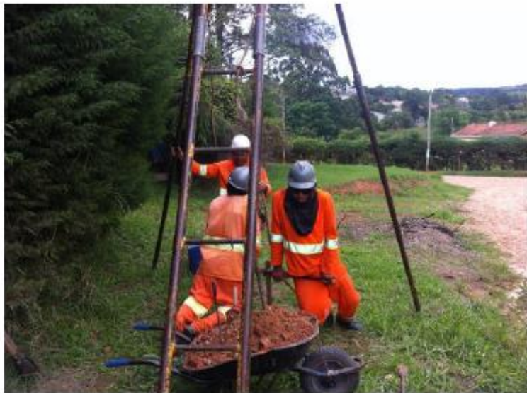
Foto 14: Realização da sondagem S-04 para a instalação do poço PM-04, no entroncamento da Estrada Municipal Antônio Sesti na AID do empreendimento.
