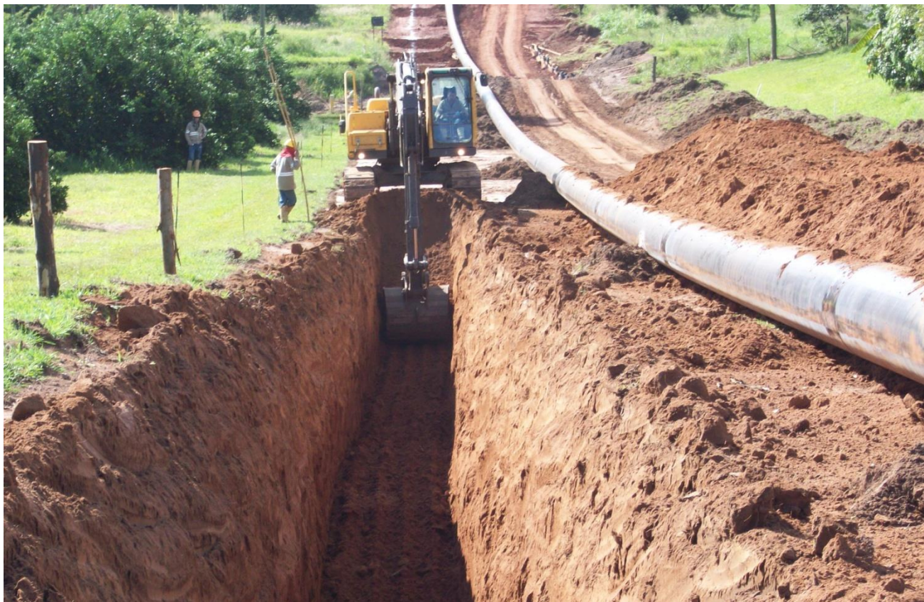
Abertura da vala
