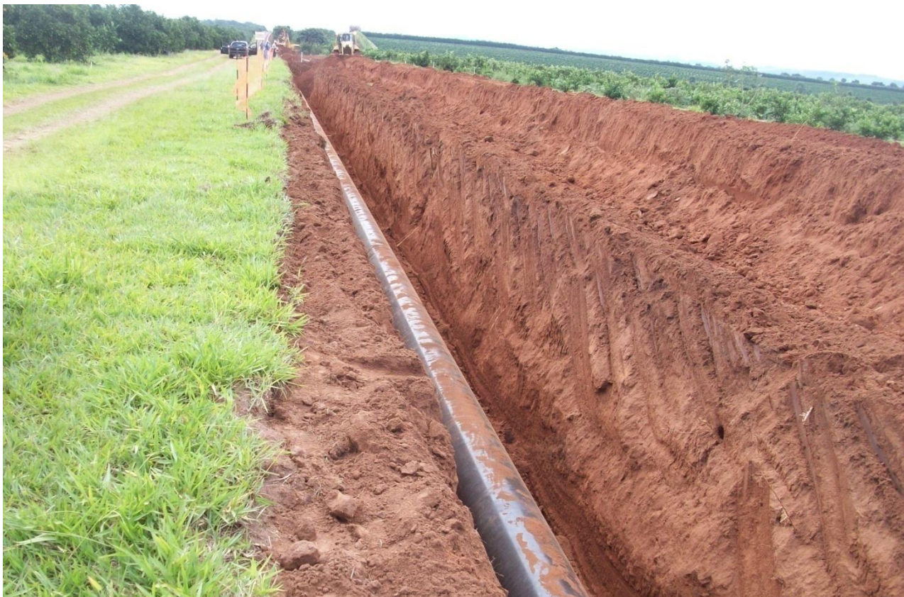
Coluna no fundo da vala
