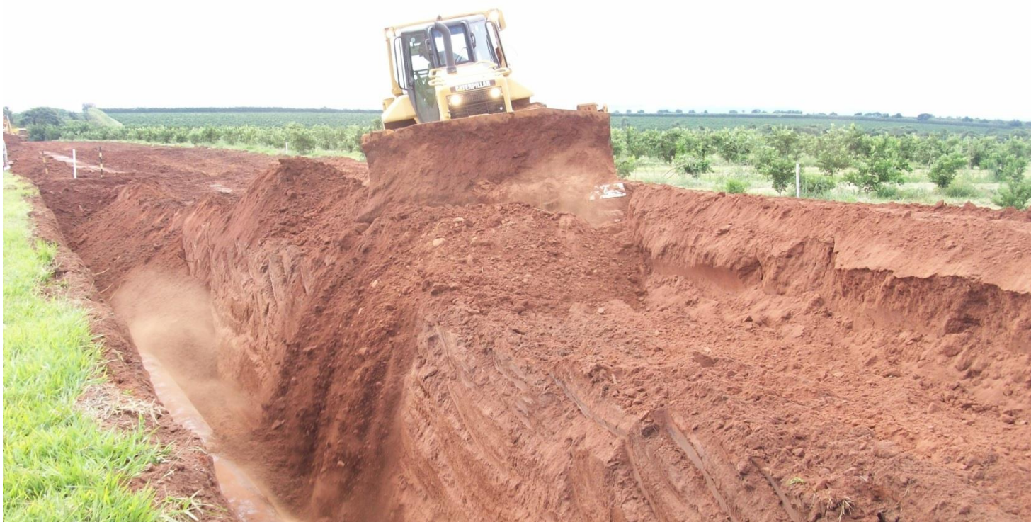
Cobertura da vala
