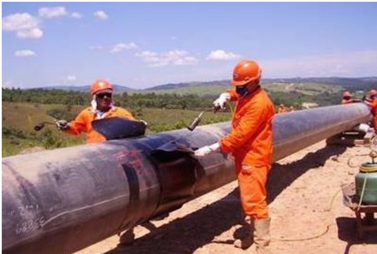
Revestimento das juntas
