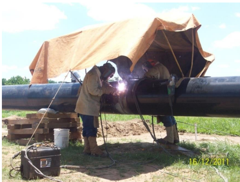
Montagem das colunas - soldas
