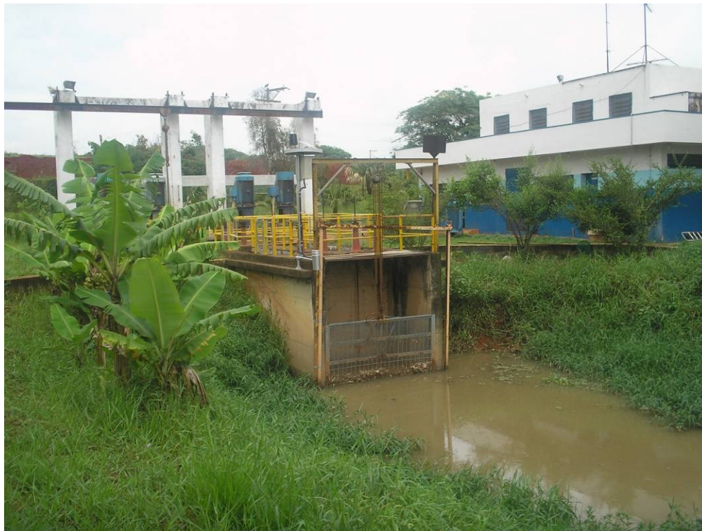
Foto 8.2 – Captação de Água para Sumaré no rio Atibaia.
