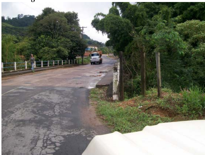
Ponte sobre o rio Camanducaia na estrada vicinal no bairro Ponte Preta.
