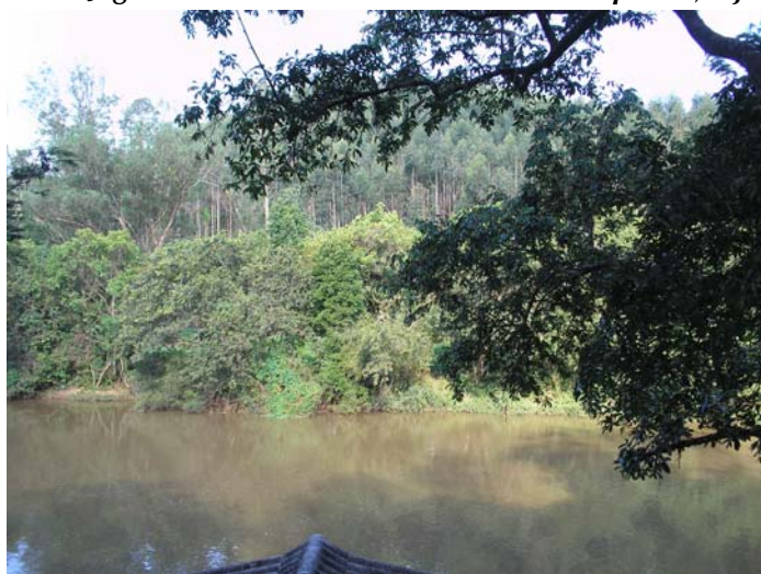
Ponto J3 – Barragem no Rio Jaguari - Vista do local do eixo, observando-se cultivo de eucalipto na ombreira direita para utilização em indústria de papel e celulose.
