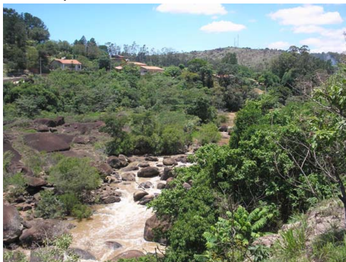
Ponto A2 – Barragem no Rio Atibaia - local do eixo, observando-se residências situadas junto à ombreira direita (vista de jusante para montante).
