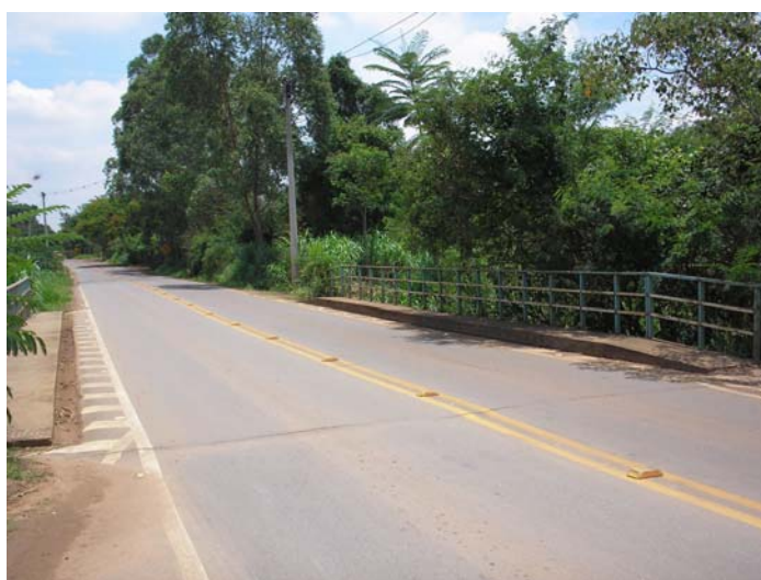
Ponto J5 – Barragem no Ribeirão Tabajara, afluente do rio Jaguari – Ponte sobre a SP 147 (Limeira-Arthur Nogueira) sujeita a inundação pelo lago.
