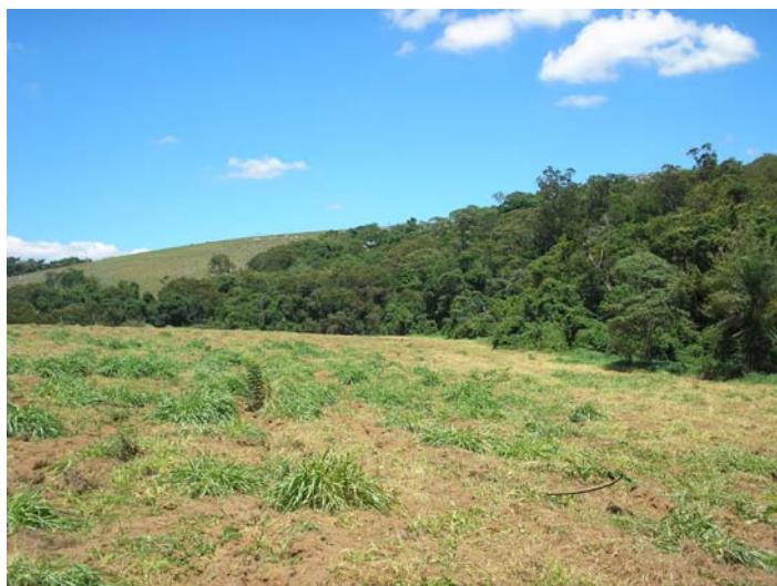
Ponto A1 – Barragem Fazenda Velha, no córrego Fazenda Velha, afluente do rio Atibaia – vista do local do eixo, de montante para jusante.
