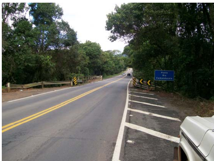
Ponte da SP-08 sobre o rio Camanducaia.
