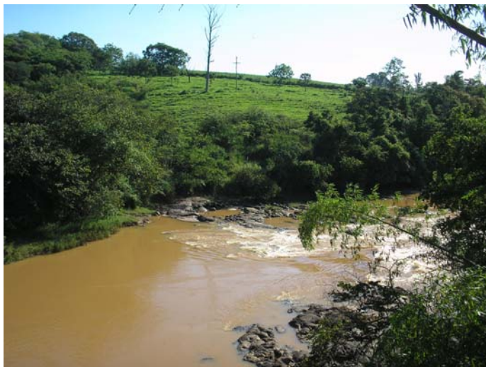
Ponto J6 – Barragem no Rio Jaguari – Local do eixo e ombreira esquerda. Trecho encachoeirado, contribuindo para reaeração das águas do rio.
