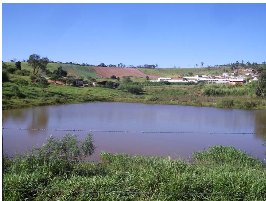
Ponto I2 – Lago do Camata. Vistas da bacia de contribuição do lago, dentro da área urbana de Itatiba.
