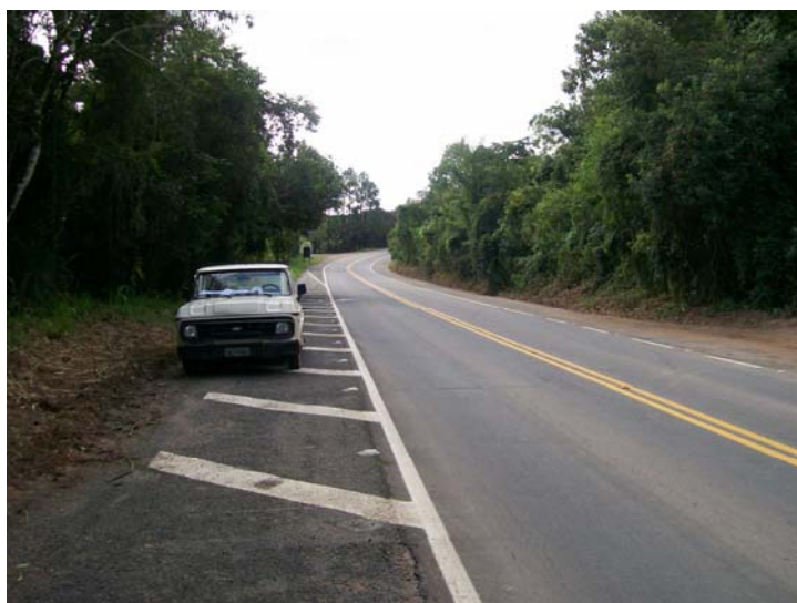
Aspecto da Estrada sobre a margem direita do rio Camanducaia.
