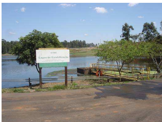
Figura 2. Saída do efluente na lagoa de estabilização (Ponto 3).
