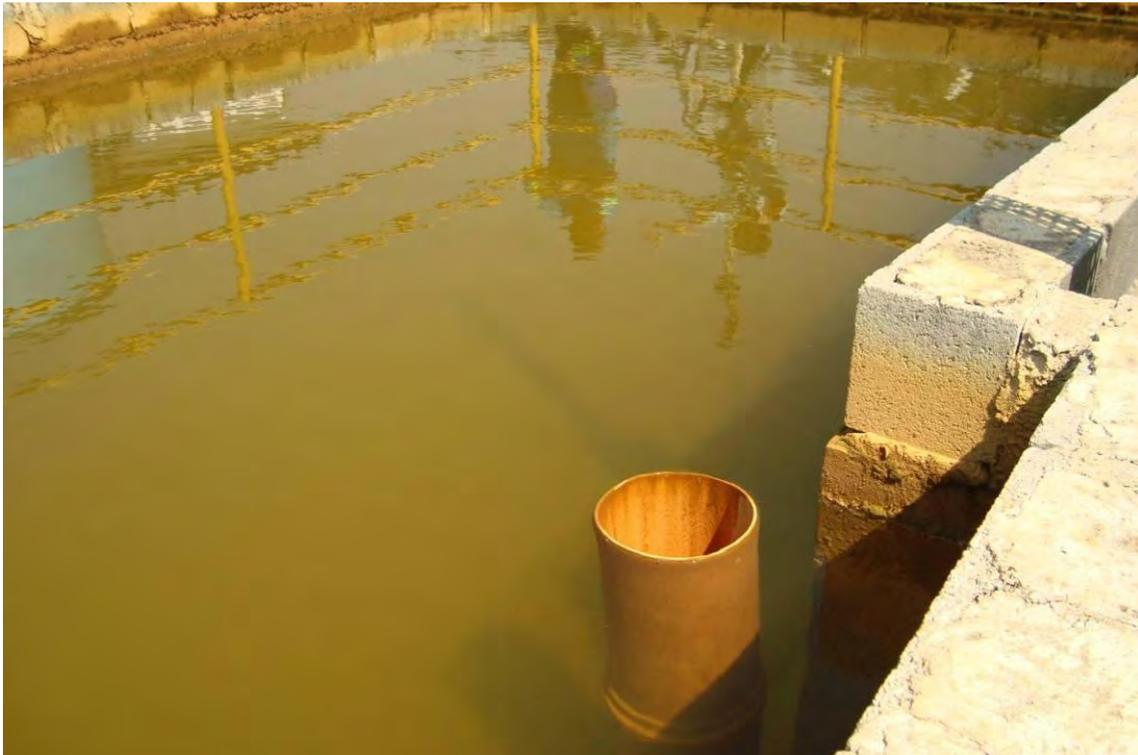
**Figura 5.5.6. 2: Detalhe da saída do efluente sobrenadante que retorna ao tratamento.**
