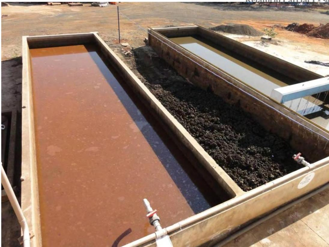
**Figura 5.5.1 3: Leitões de secagem do lodo de ETA.**
