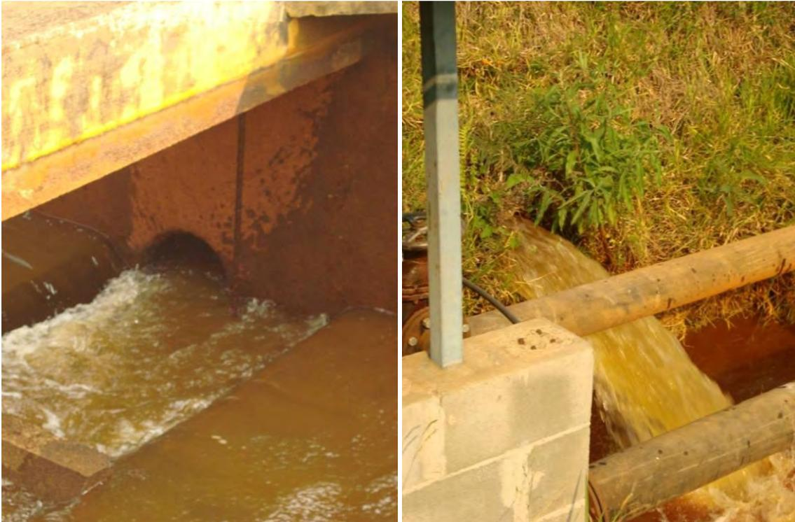
**Figura 5.5.4. 2 :Água de lavagem dos filtros sendo conduzida para lagoa de decantação.**
