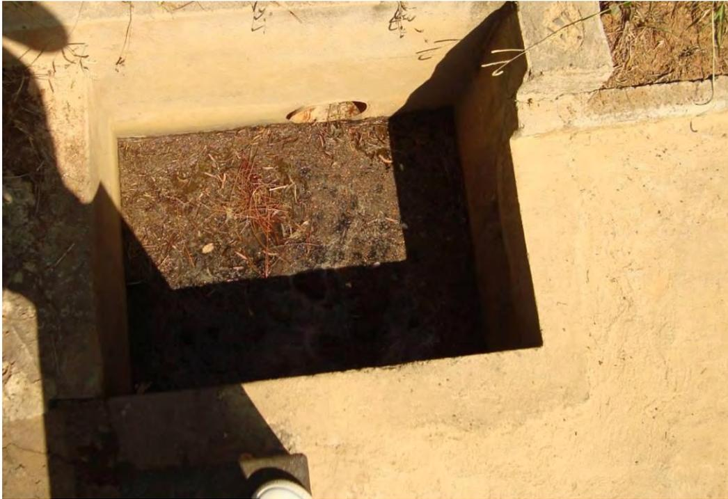
**Figura 5.5.5. 2: Poço de recebimento dos efluentes.**
