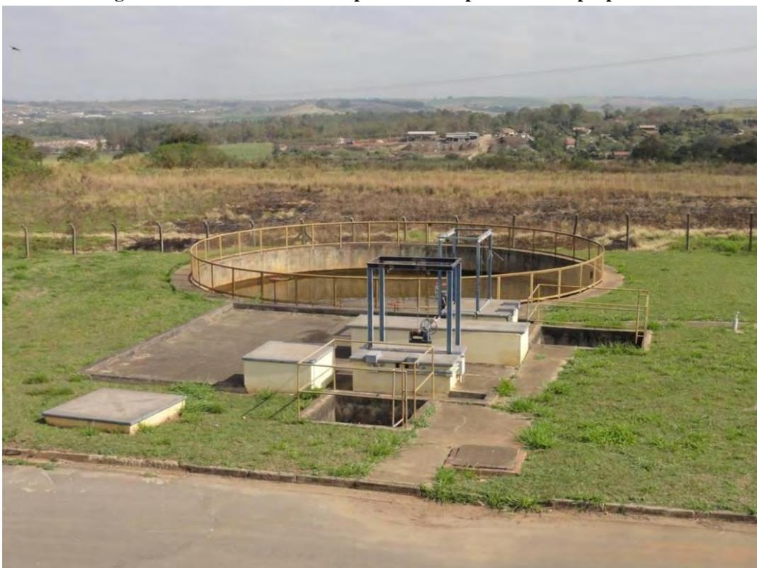
**Figura 5.5.2. 7: Tanque de Clarificação da ALF da ETA Capim Fino.**
