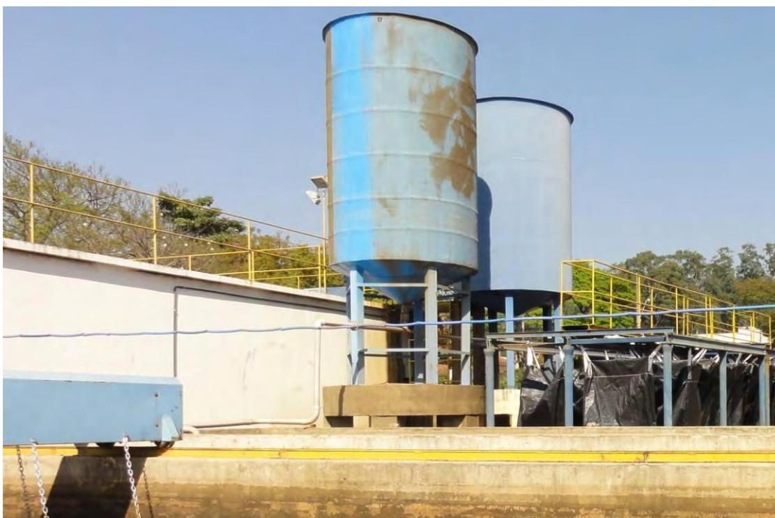
**Figura 5.5.1. 2. Decantadores para o Lodo de ETA.**
