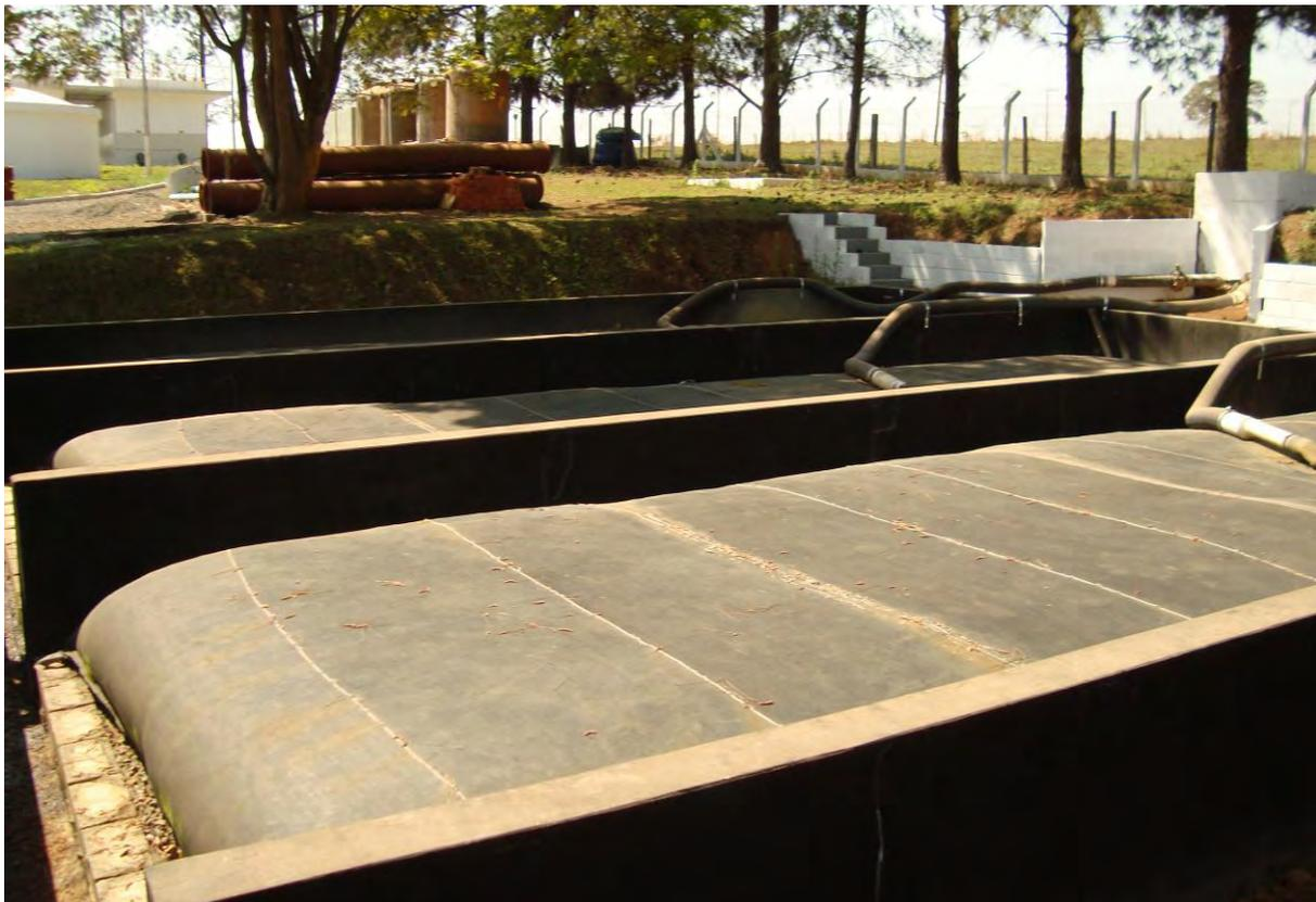
Figura 5.5.5. 1: Vista geral dos bags instalados na ETA.
