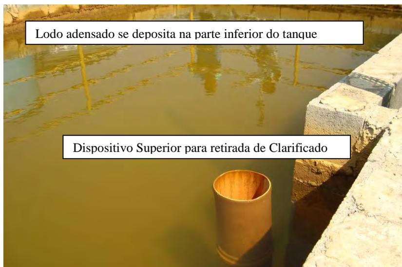
**Figura 3.1.4. 1: Tanque de adensamento de lodo de ETA.**
