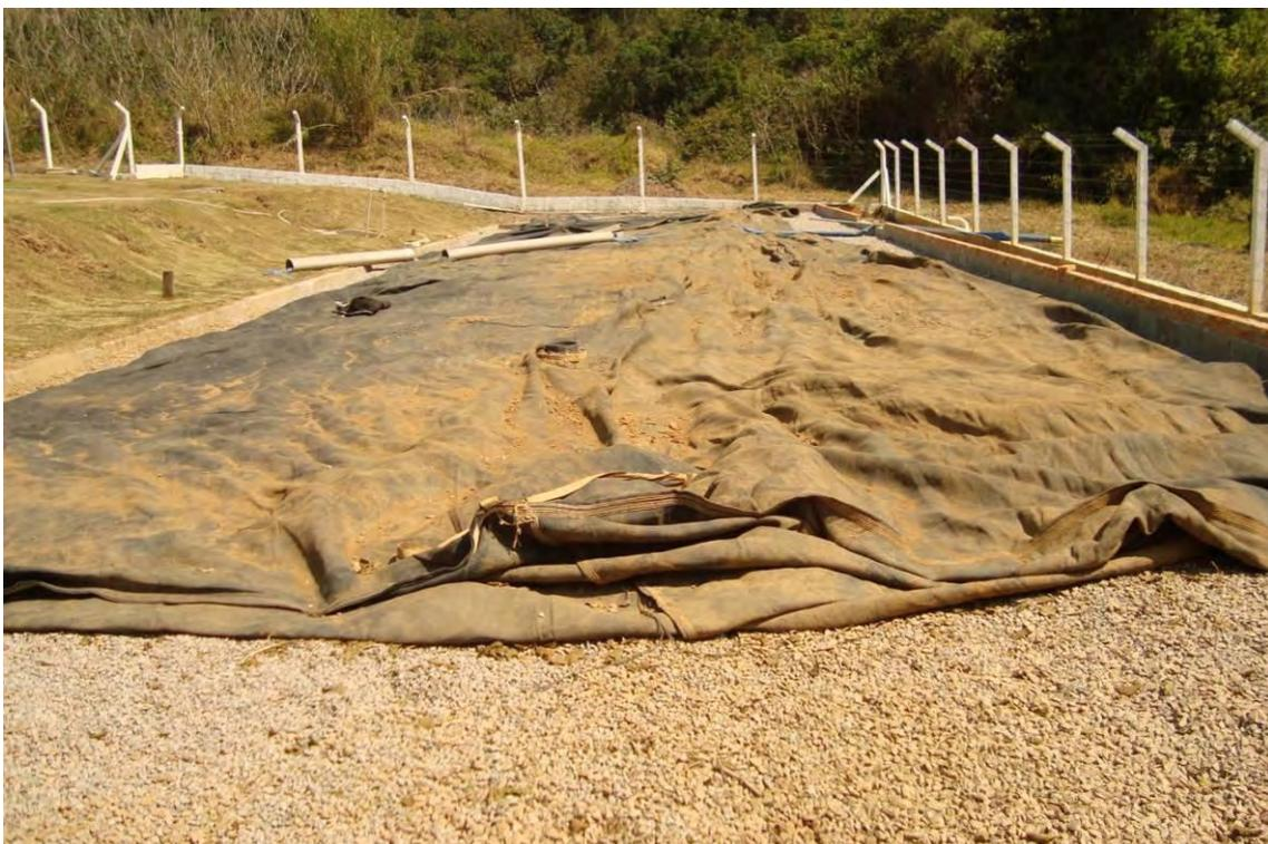
**Figura 5.5.6. 3: Detalhe do local onde está instalado o bag para acondicionamento do lodo.**
