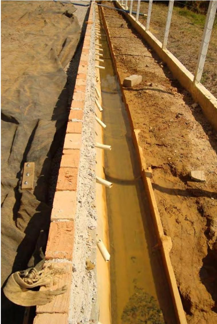
**Figura 5.5.6. 4: Detalhe da canaleta coletora do efluente drenado dos bags.**
