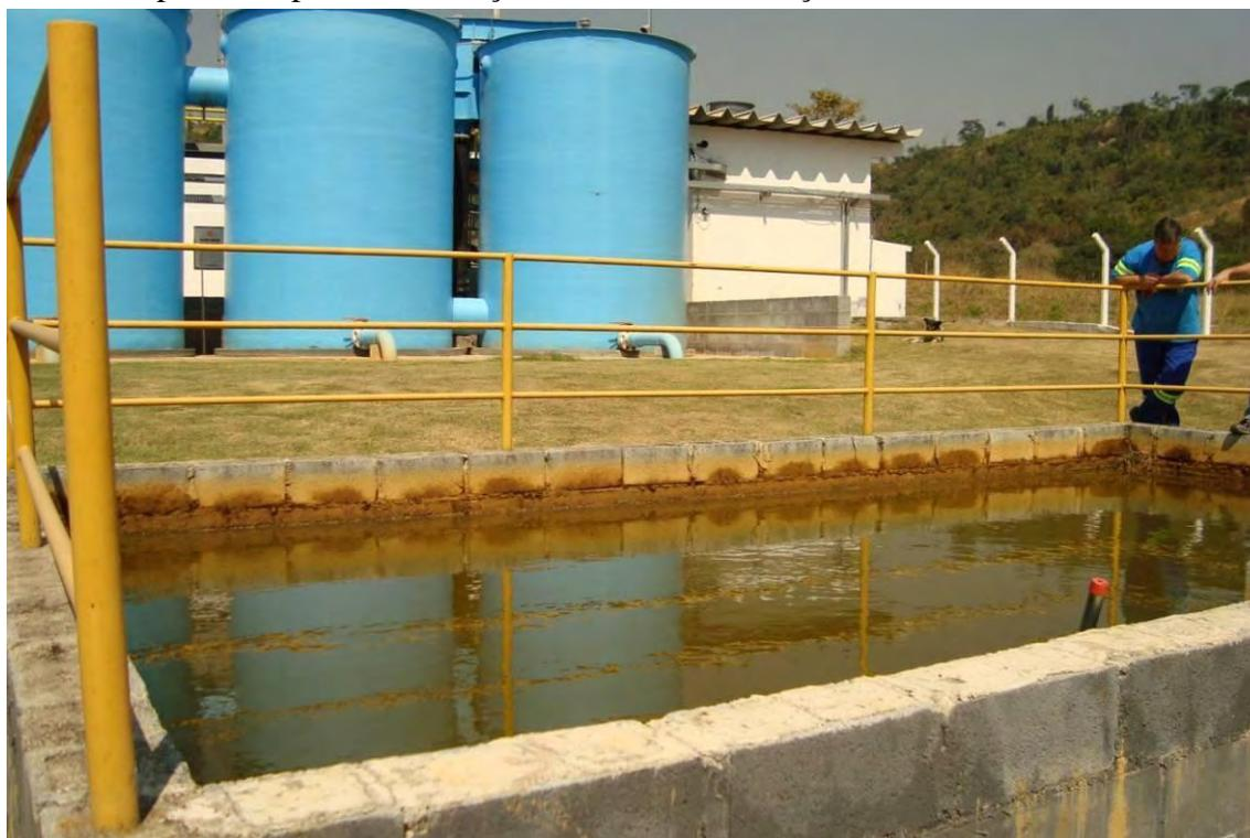
**Figura 5.5.6. 1: Tanque de decantação do lodo de ETA.**
