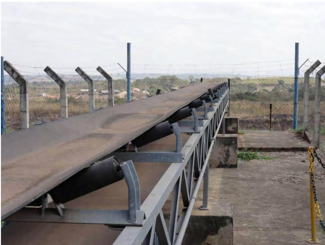
**Figura 5.5.2. 6: Esteira de transporte de lodo para o aterro próprio da ETA.**
