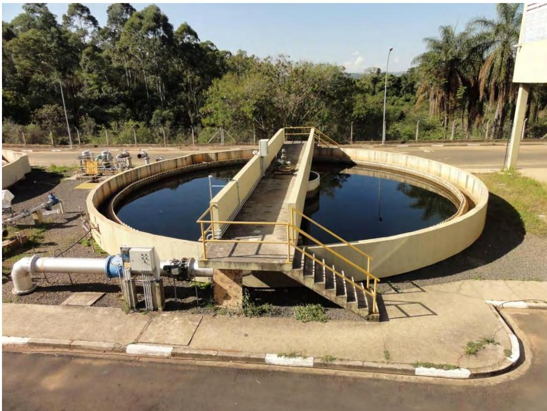
**Figura 5.5.3.4: Tanque de adensamento.**
