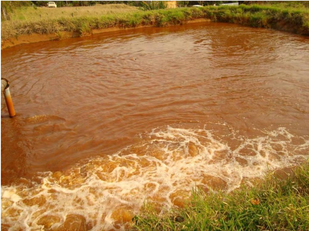
**Figura 5.5.4. 4: Vista parcial da lagoa de decantação em processo de enchimento.**
