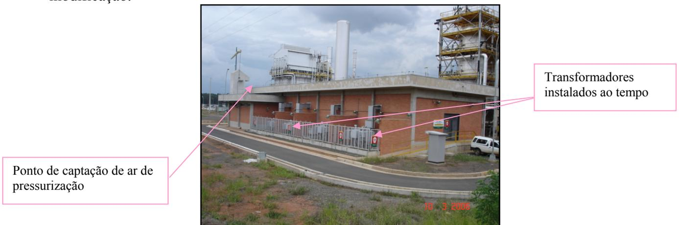
Figura nº 54 – Subestação Elétrica Existente na REPLAN
