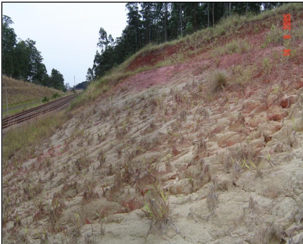
Figura nº 103 – Neste corte ferroviário a terraplanagem expôs parte dos sedimentos do Sub-Grupo Itararé de coloração cinza clara, na base do talude. A parte média do talude (rosa/avermelhada) são sedimentos cenozóicos e sobre eles se desenvolve o solo latossólico vermelho.
