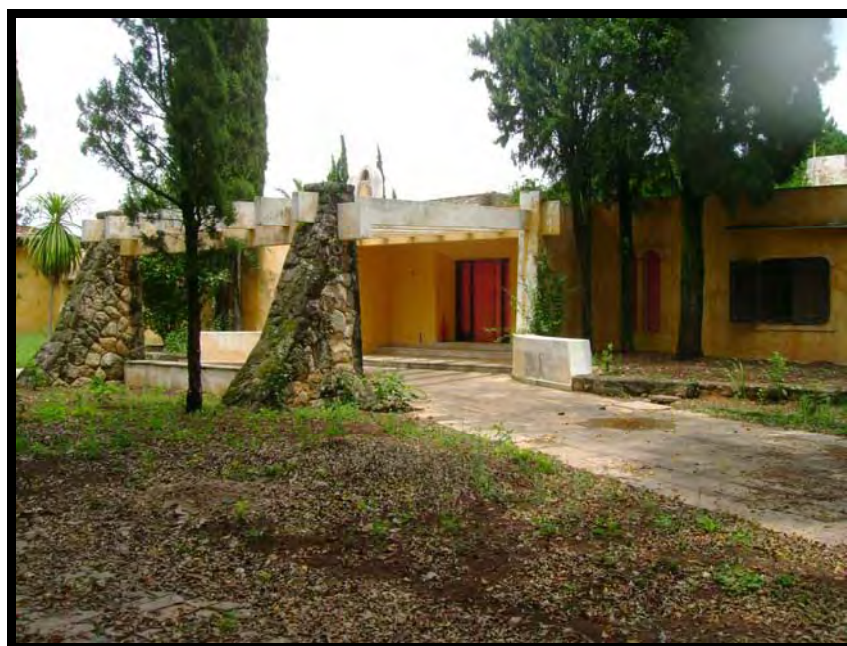
FIGURA 3.1-1: Vista parcial da sede do antigo haras.
