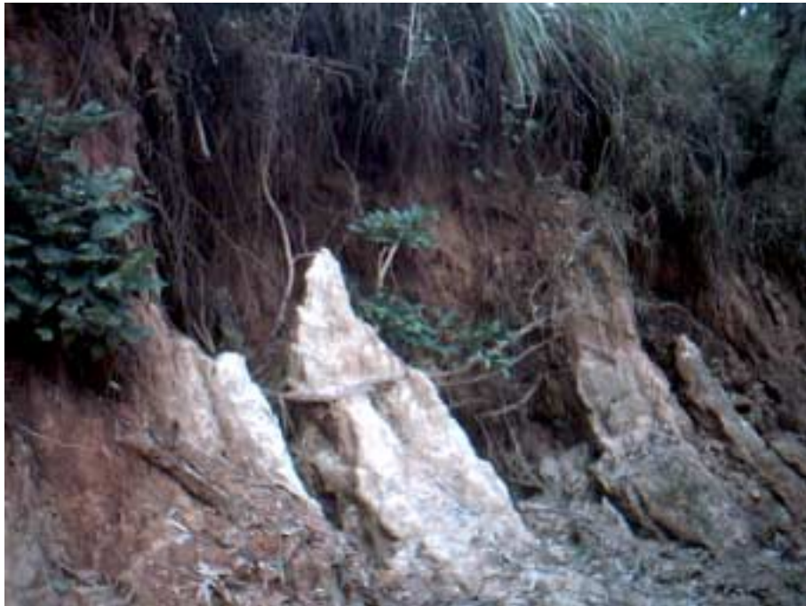
Foto 5.2.2-8 – Solo de alteração com estruturas reliquiares, controlando os processos erosivos locais, em taludes de estrada secundária.
