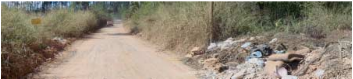
F.55 – Entulho em trecho da CAM 10 próximo ao trevo de acesso
