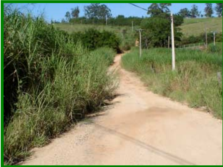
Foto 09: Vista do trecho da CAM 10 a ser alargado, para travessia sobre pequeno curso d'água, onde será suprimida apenas gramínea em Área de Preservação Permanente.
