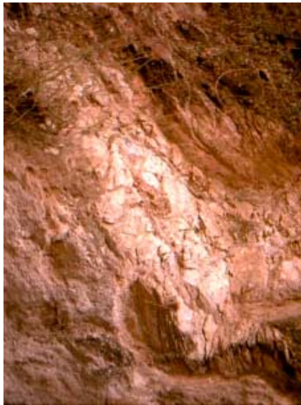
Foto 5.2.2-4 – Gnaisses xistosos com veio pegmatítico quartzo - feldspático, na estrada de acesso da Fazenda Jatibaia.
