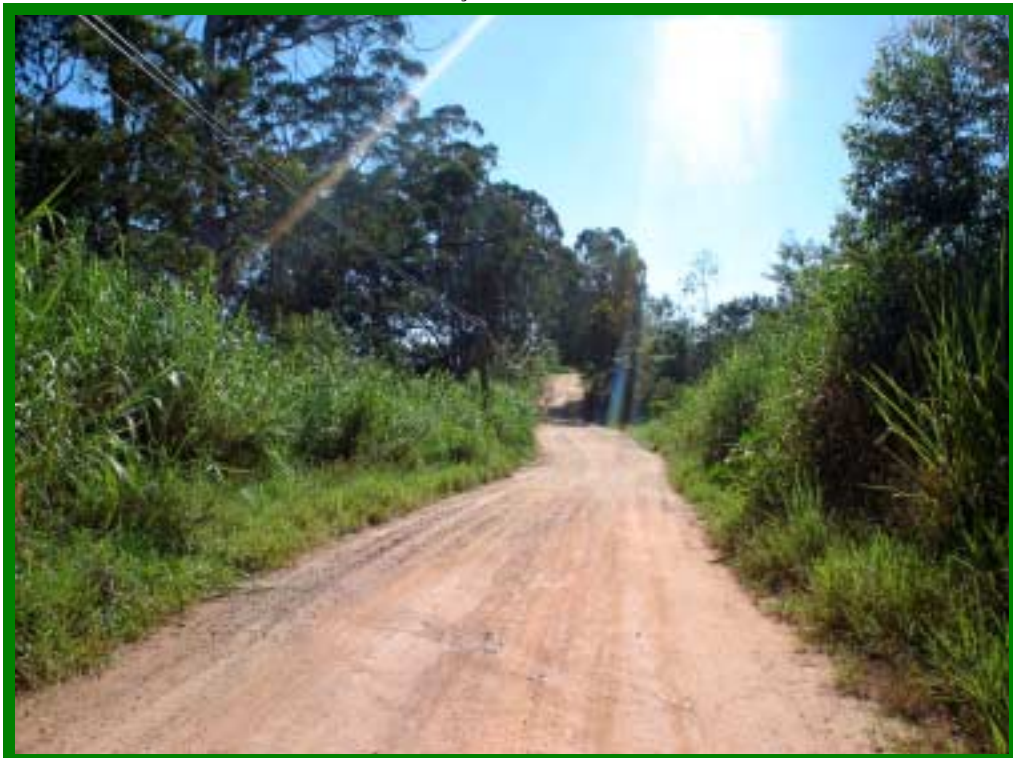
Foto 10: Vista do trecho seguinte da CAM 10 a ser alargado, onde será suprimido apenas gramíneas e eucaliptos isolados.
