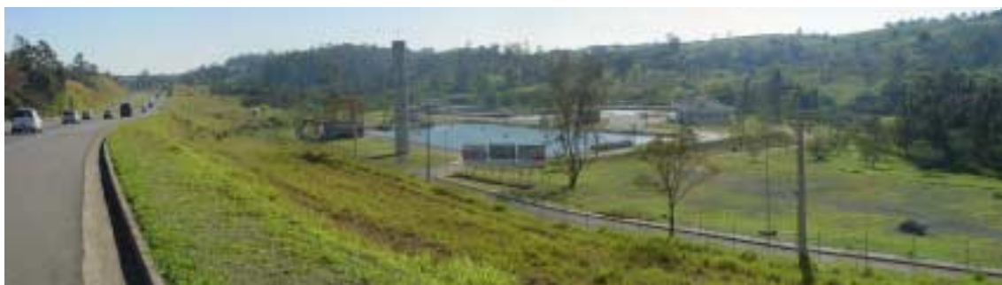
F.1 – ETE Samambaia, Ideira à SP 083 – Anel Viário Rodovia Roberto Magalhães.
