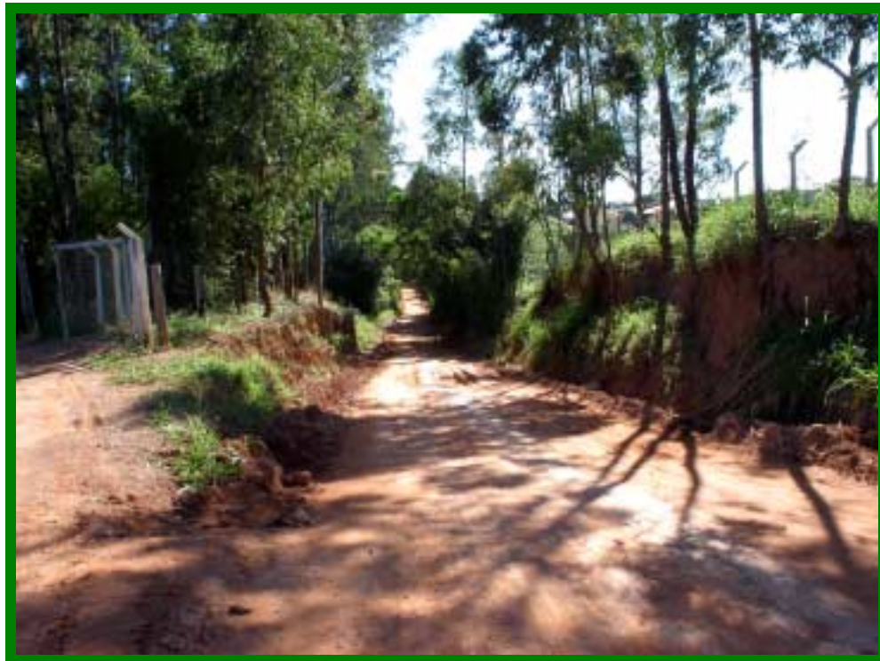
Foto 07: Vista do trecho da CAM 10 a ser alargado para execução da avenida, onde observa-se apenas a necessidade de supressão de arbóreas exóticas isoladas (eucaliptos), em local de transposição sobre um pequeno curso d'água existente na divisa com a Fazenda Jatibaia.
