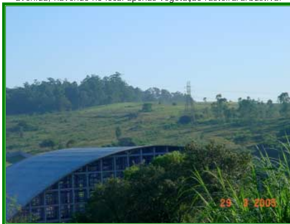
Foto 04: Vista ao fundo e a esquerda, eucaliptal que será atingido em parte pela obra, observando também área de pastagem a ser ocupada pela avenida.
