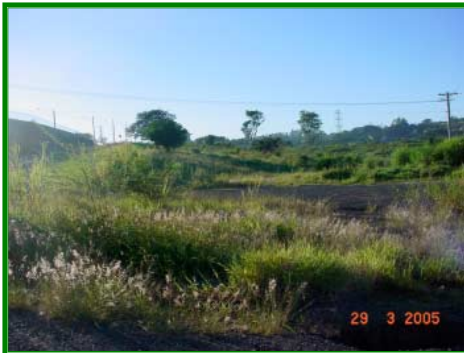
Foto 01: Vista do local próximo da Rodovia D. Pedro I, onde se iniciará a obra de prolongamento da Avenida Mackenzie, observando-se apenas vegetações rasteiras, arbustivas e árvores isoladas de pequeno porte.
