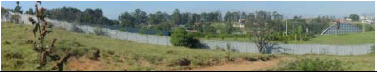
F.38 – Limite da gleba da FEAC e Condomínio ao fundo no
