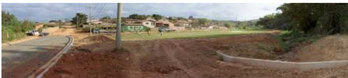
F.49 – Obras no Córrego Pires e de pavimentação no Parque Imperial
