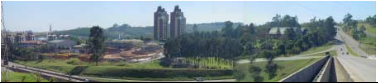
F.33 – Trevo de acesso junto à Rodovia D. Pedro I
