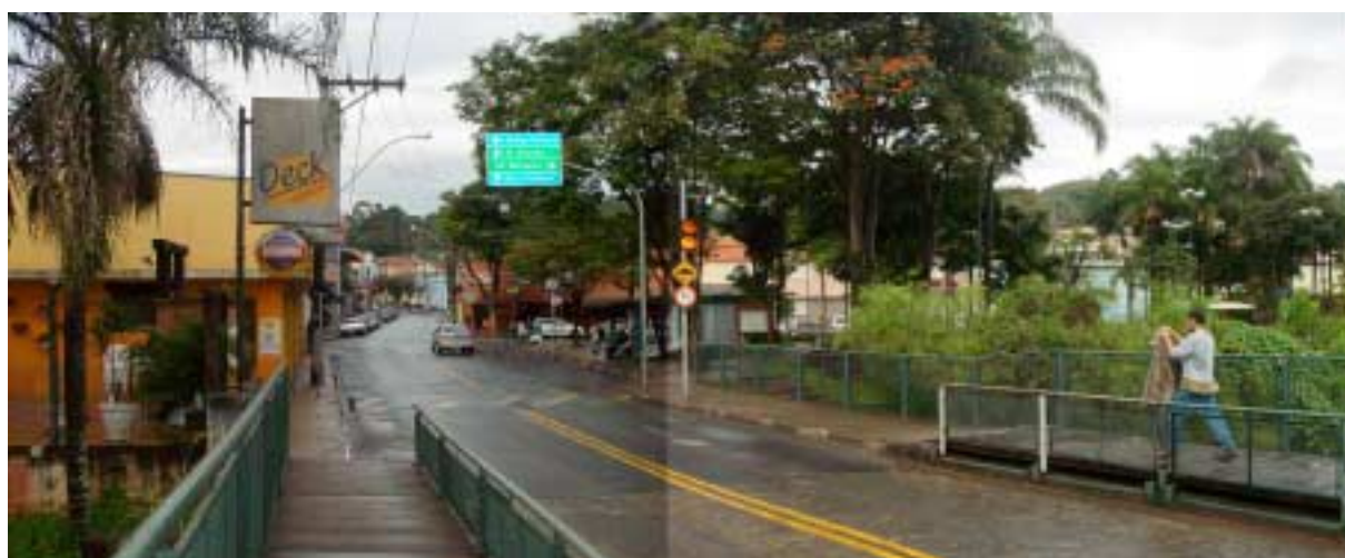
F.12 – Ponte sobre o Rio Atibaia – centro de Souza
