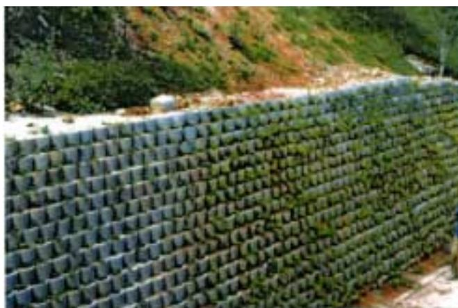
**Foto 01:** Vista de muro de arrimo com concreto articulado
