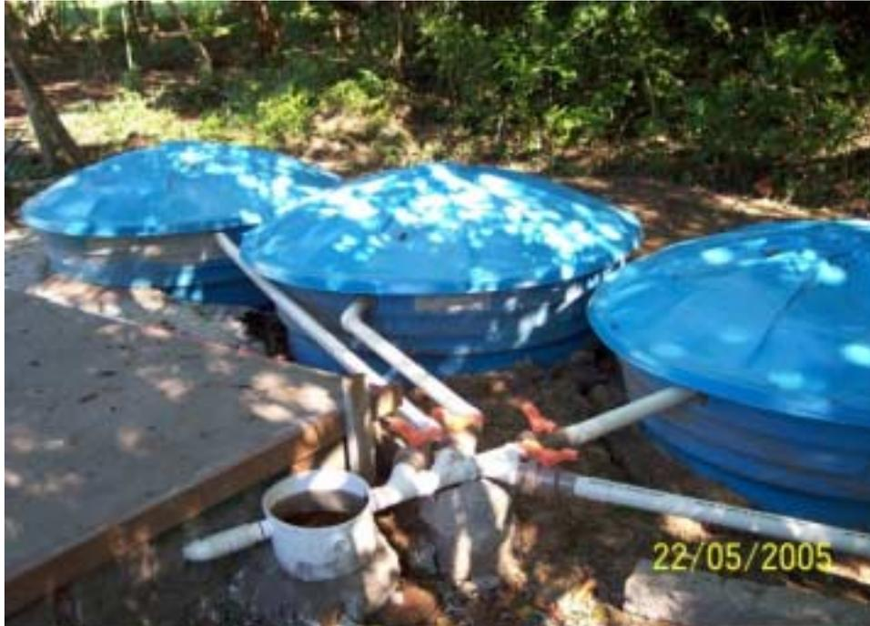
**Foto 02:** Tanques de acumulação de resíduos e sistema de registros para direcionamento dos efluentes. À esquerda, piso concretado do galpão de manipulação dos produtos químicos.
