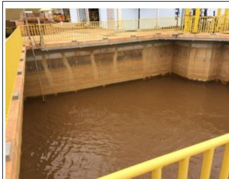
Tanque de lodo bruto, antes do sistema de adensamento e desaguamento – BS-COMBI
