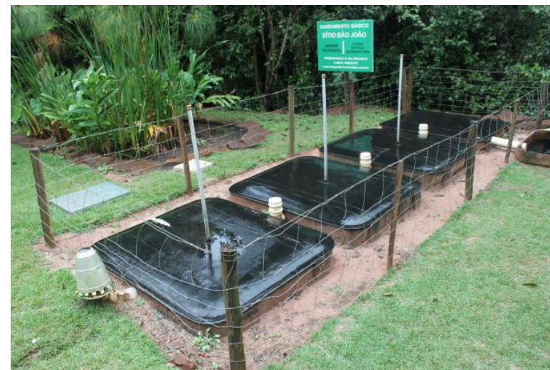
Figura 2.26 – Ilustração de fossa séptica biodigestora.
