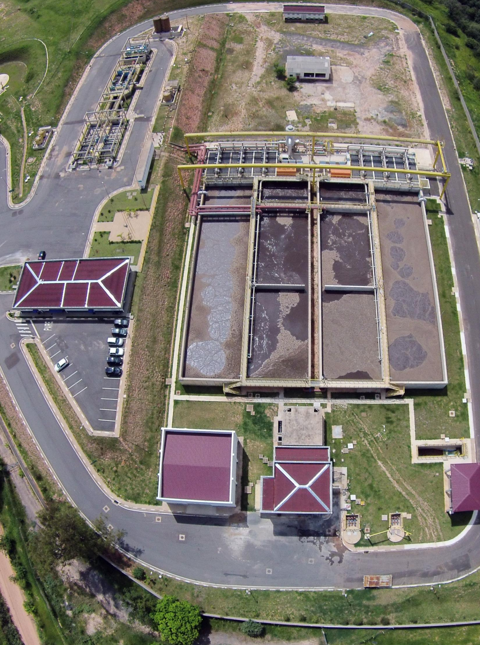
ETE Estação Produtora de Água de Reuso (EPAR) - Capivari/II (Localizada no município de Campinas) Fonte: Marcos Lodi/Sanasa
