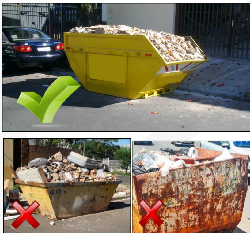
Figura 162: Modelo de acondicionamento de resíduos em caçambas em boas condições.
