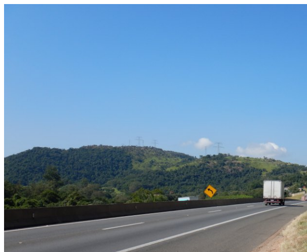
■ Relevo de Morros com Serras Restritas
