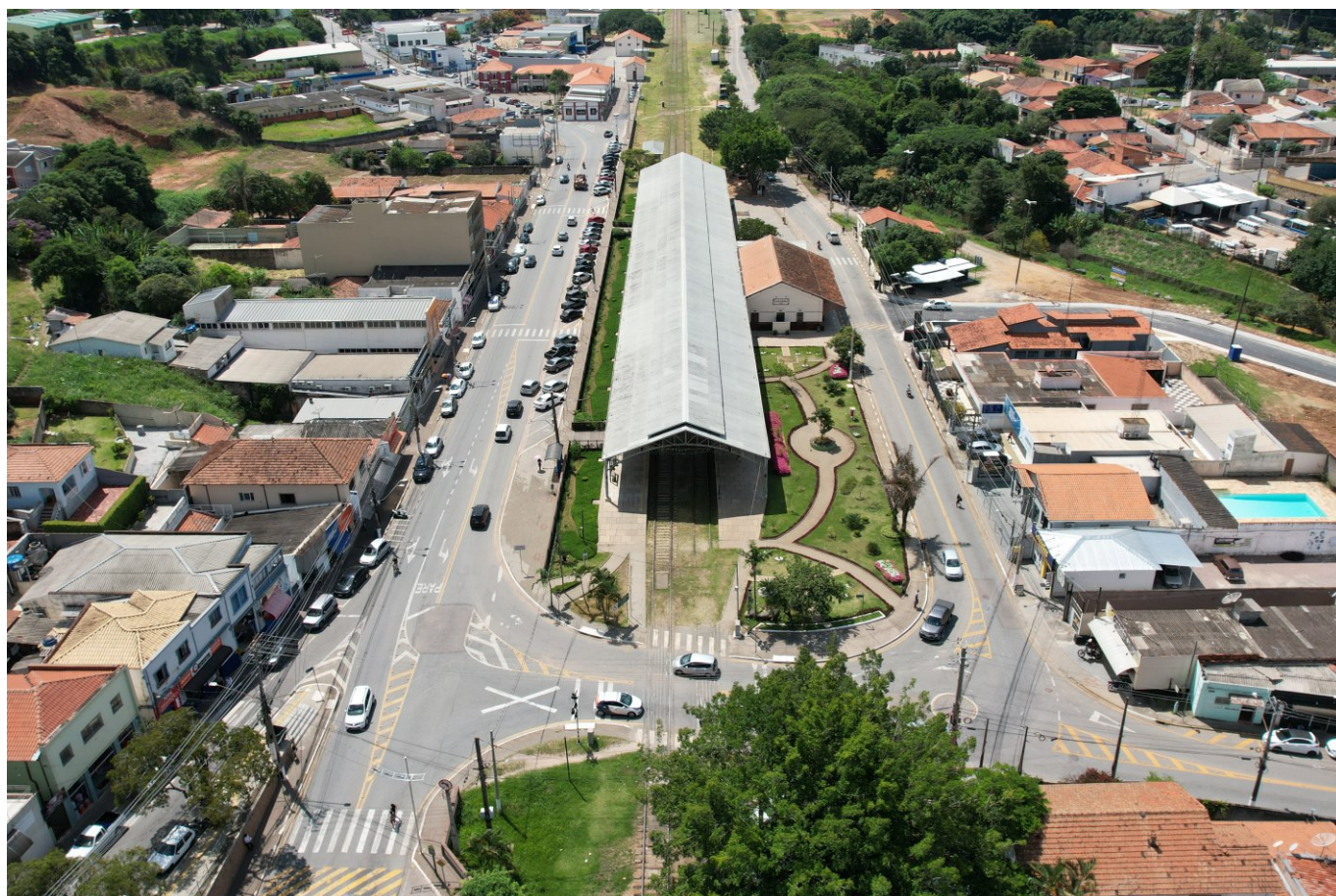
Estação Ferroviária de Louveira
