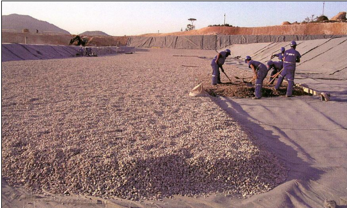
Figura 10 - Implantação do colchão drenante
