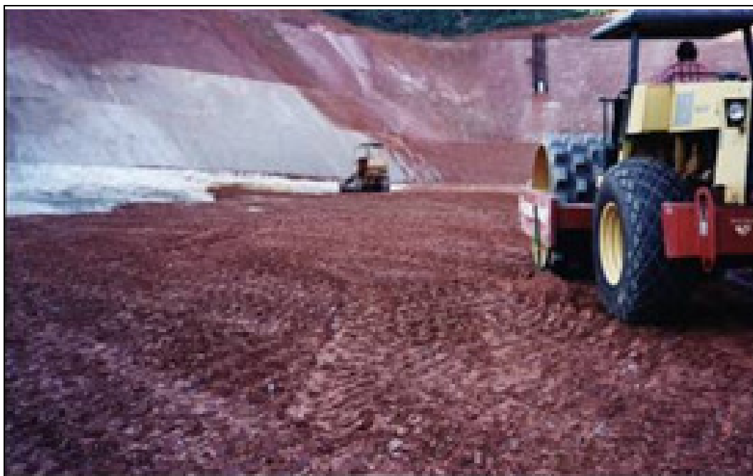
Figura 7 - Implantação da camada de argila de impermeabilização inferior
