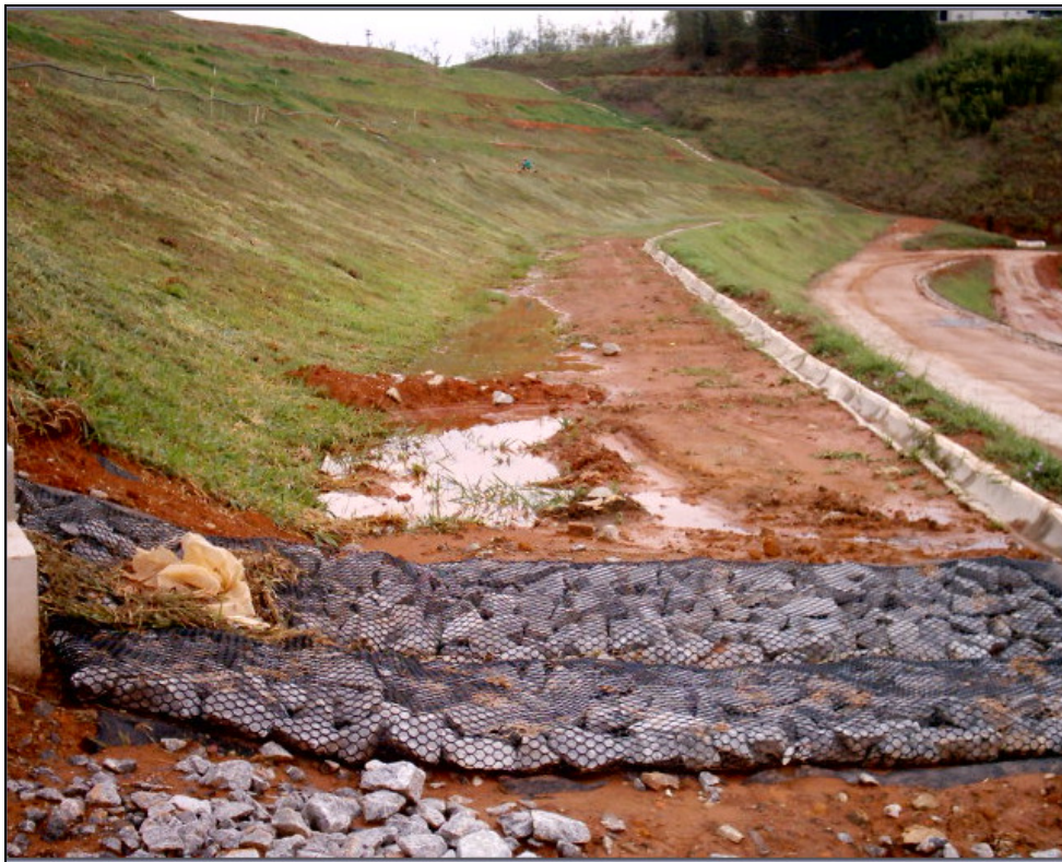
Figura 22 - Gabião e dreno permanente de águas pluviais
