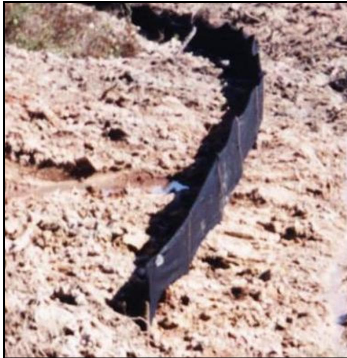
Figura 26 – Sistema de fixação do bidim com pedaços de vergalhão metálico
