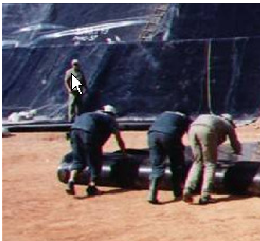
Figura 8 - Implantação de manta de PEAD para impermeabilização inferior
