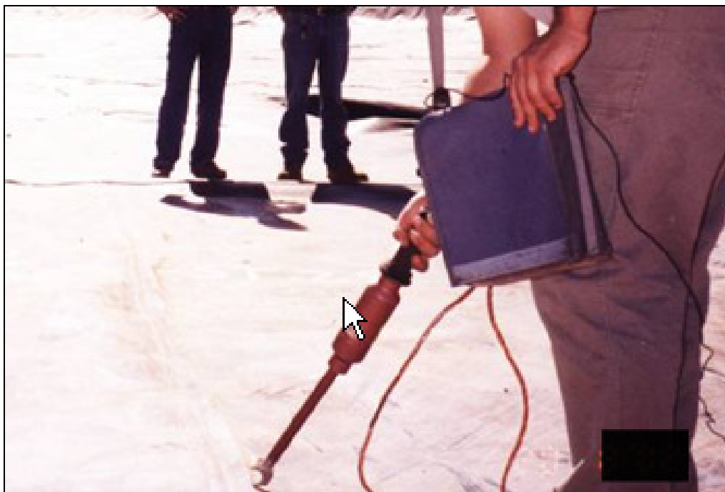
Figura 9 - Teste de solda das mantas de PEAD instaladas, visando a melhor qualidade de impermeabilização
