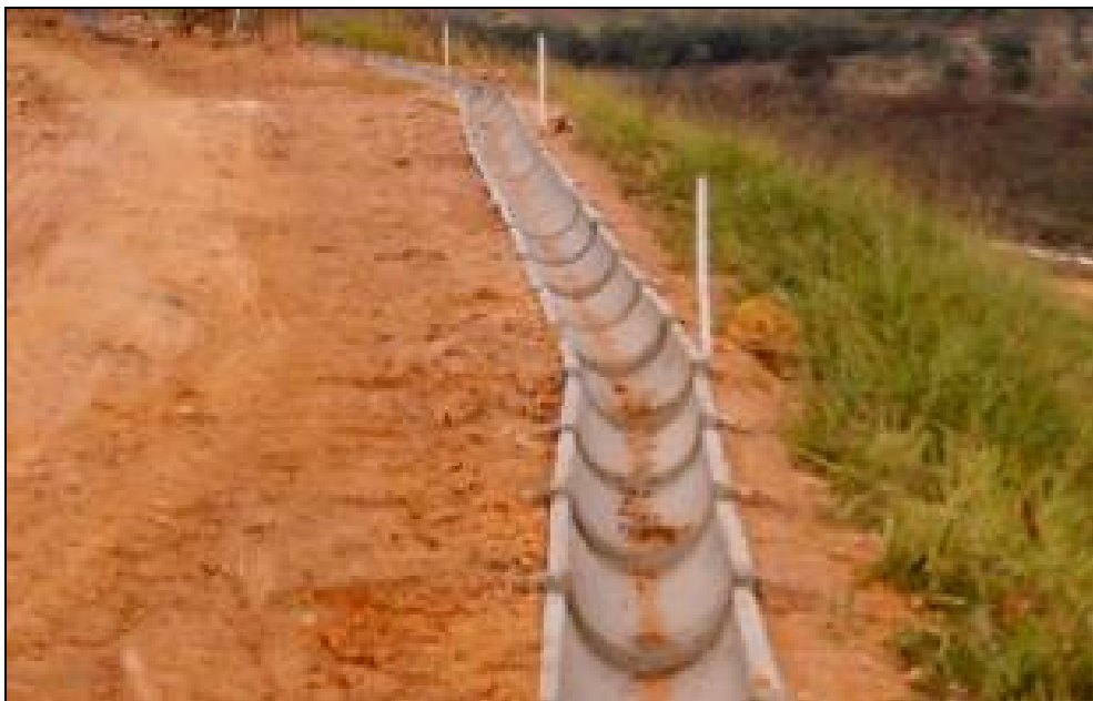
Figura 21 - Drenos permanentes de águas pluviais
