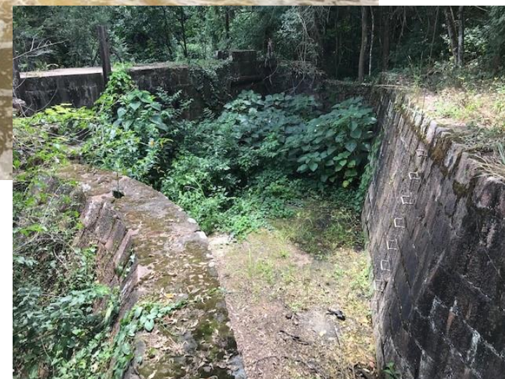
Quilombo I – Barramento e Câmara de Carga
