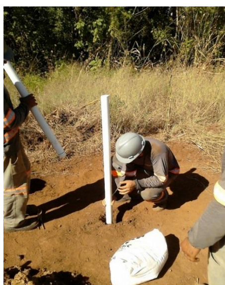
Figura 7.2.4.2-7: Sondagem e instalação do PM-03
