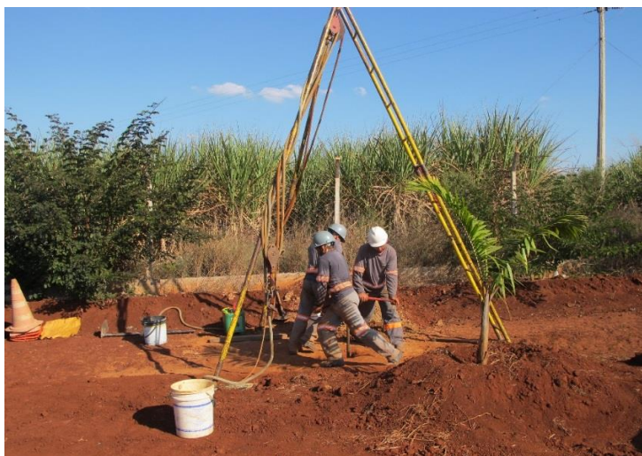
Figura 7.2.4.2-8: Perfuração do PM-04 na porção Topograficamente alta do empreendimento. Profundidade final 26,6m
