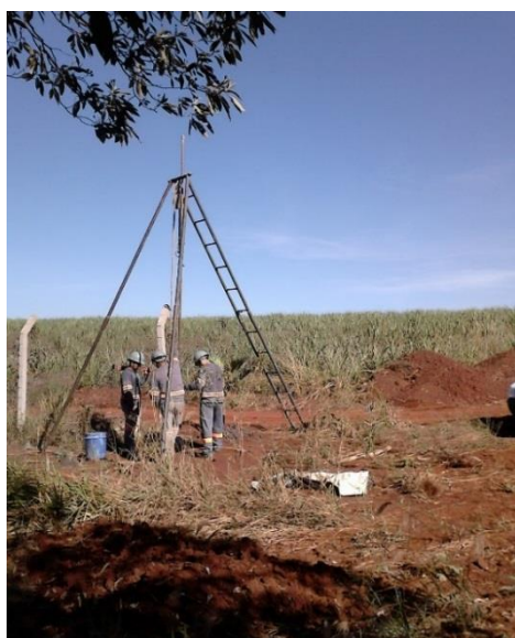
Figura 7.2.4.2-7: Sondagem e instalação do PM-03
