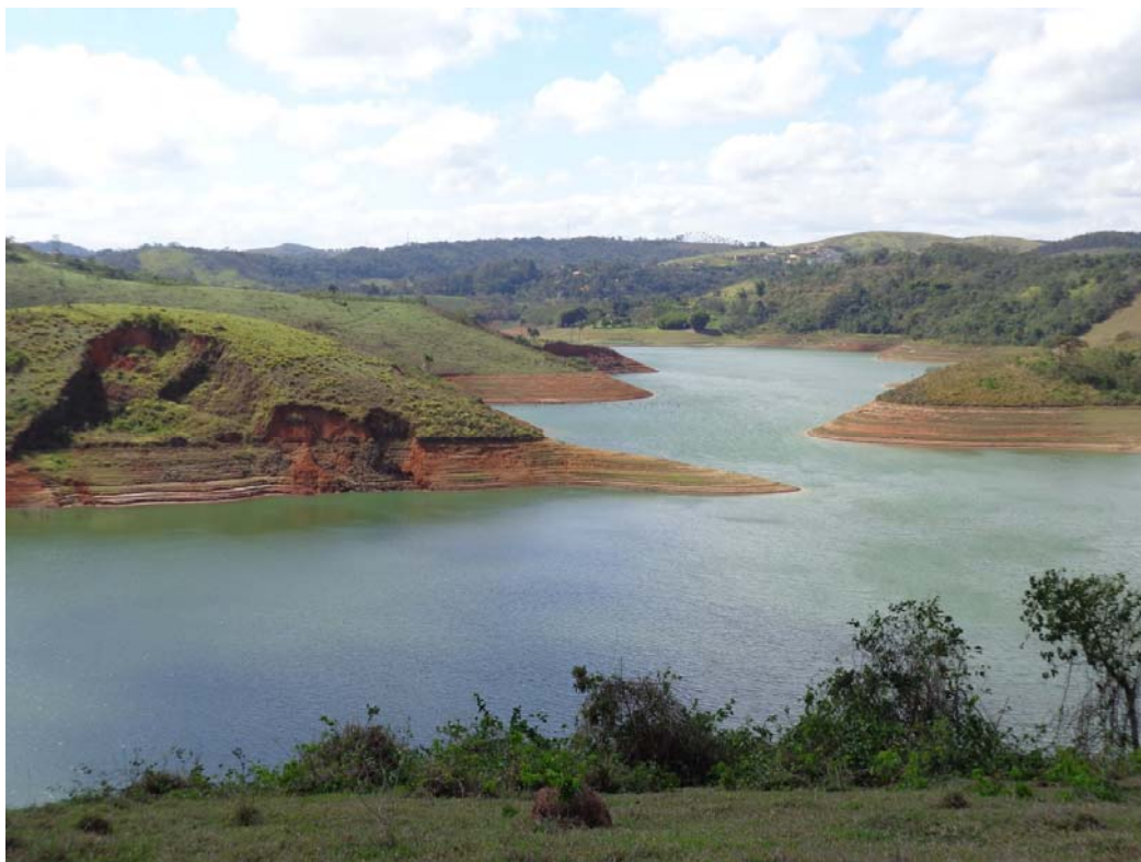
Cicatriz de grande deslizamento e erosões em encosta marginal do reservatório Jaguari, resultantes da descida abrupta do nível da água do reservatório.
