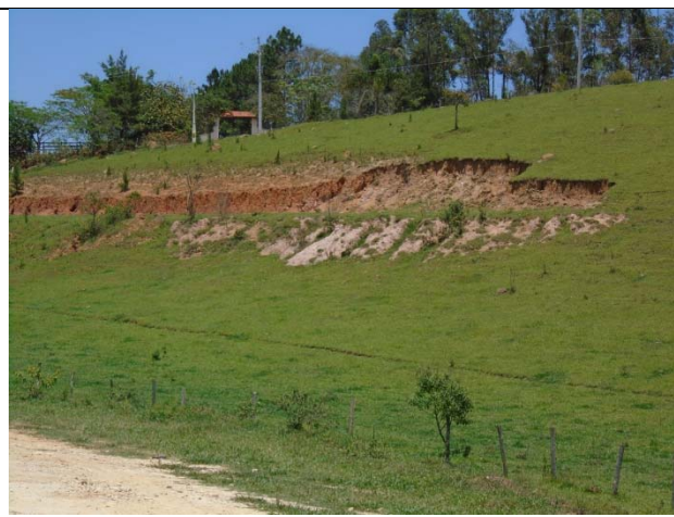
Foto 4 – Vertente com declividade D2, observando-se a erosão em talude de corte em estrada de acesso em uma propriedade rural.
