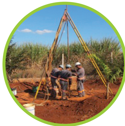
Sondagem com trado manual e sem lama de perfuração (PM-04)
