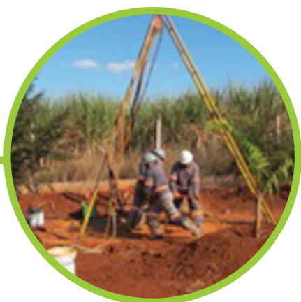
Perfuração do PM-04 na porção Topograficamente alta do empreendimento. Profundidade final 26,6m
