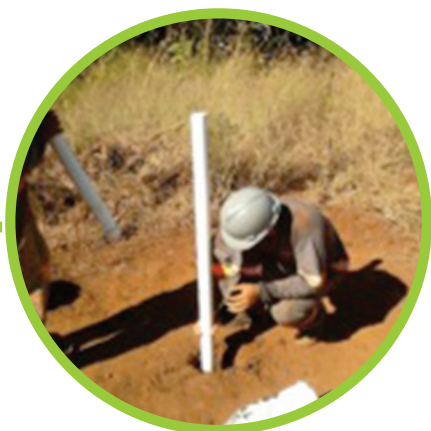
Sondagem e instalação do PM-03
