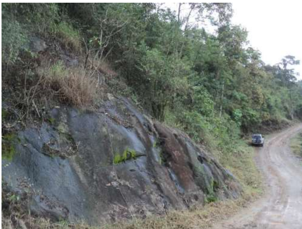
Foto 3: Afloramento de rocha (Rocha sã, ocasionalmente fraturada).
