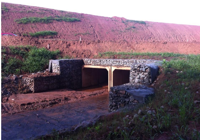
Foto 6: Aspecto da estrutura hidráulica para drenagem do Ribeirão Pinhalzinho na base do talude da futura Via Perimetral de Itatiba.
