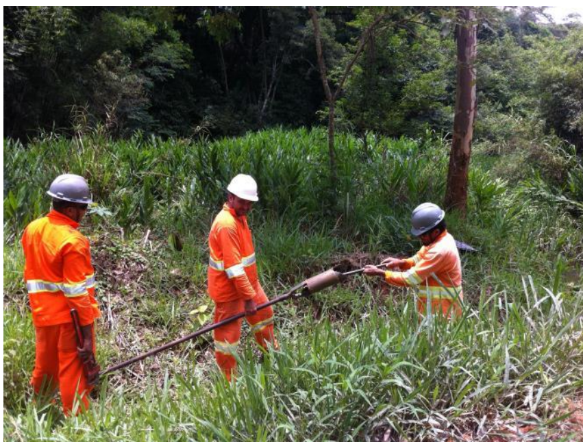
Foto 12: Realização da sondagem S-03 para a instalação do poço PM-03, na margem direita do Ribeirão Pinheirinho.
