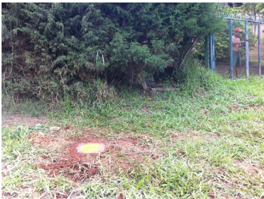
Foto 15: Aspecto final do poço de monitoramento PM-04 com câmara de calçada ao nível do solo.
