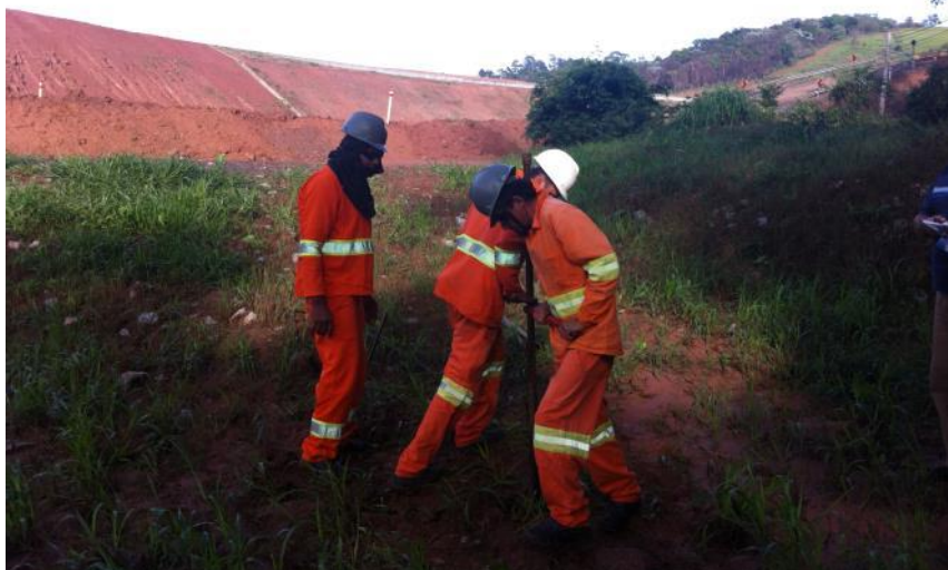
Foto 7: Realização da sondagem S-01 para a instalação do poço de monitoramento PM-01, na margem direita do Ribeirão Pinhalzinho.
