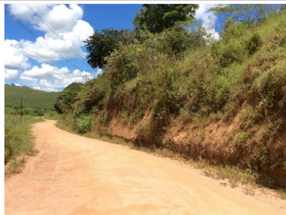
Foto 9.1.3.2-2: Estaca 78, km 1+120 – sentido Itatiba. Corte realizado para a construção de estrada rural, com presença de material saprolítico.
