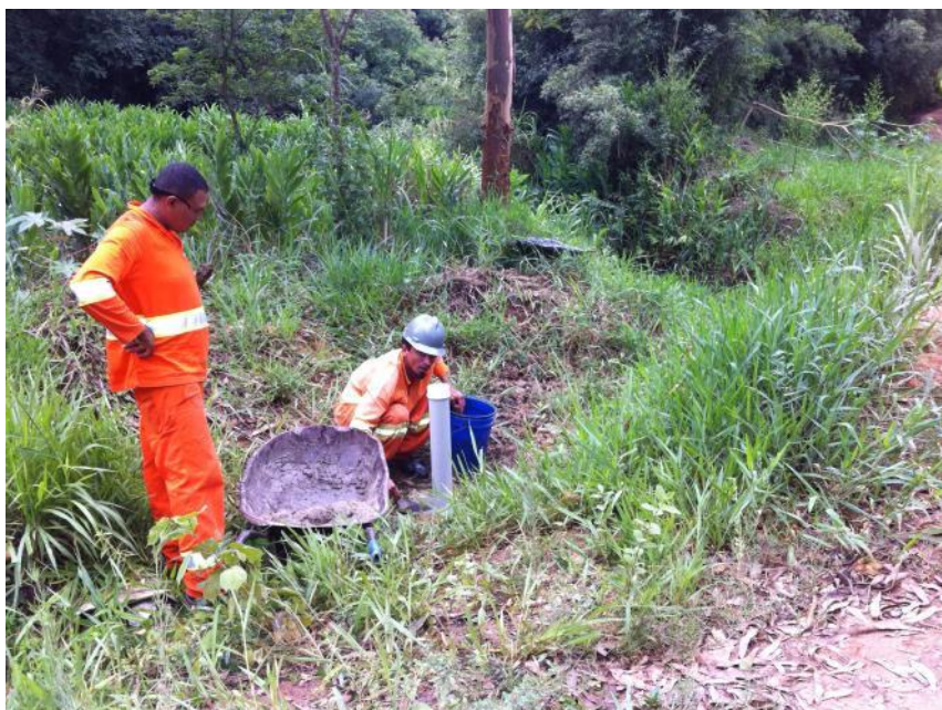
Foto 16: Realização de acabamento de poço acima do nível do terreno.
