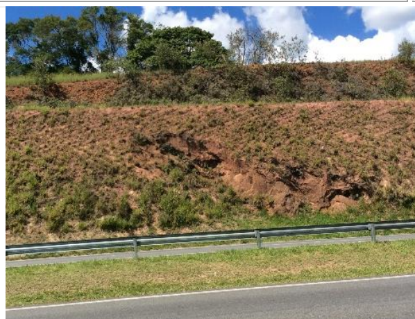
Foto 9.1.3.2-11 e 12: Chegada da Perimetral na Rodovia Dom Pedro. Nota-se rocha intrusiva exposta devido ao corte realizado na construção da rodovia.
