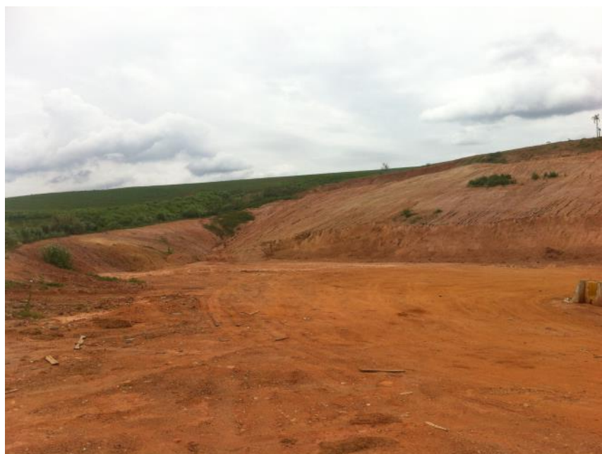
Foto 2: Corte de terreno no local de início da Via Perimetral de Itatiba.
