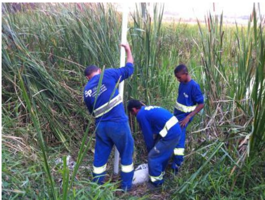
Foto 14: Instalação do poço de monitoramento PM-04 às margens do Ribeirão Capivari-Mirim.
