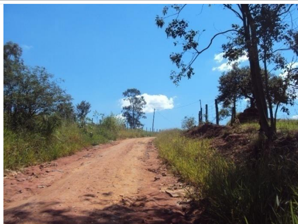
Foto 7.1.3.2-6: Estaca 1470, km 21+500 – Estrada com processos erosivos superficiais.
