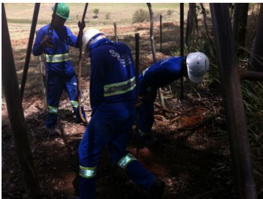
Foto 12: Realização da sondagem S-02 para a instalação do poço PM-02.
