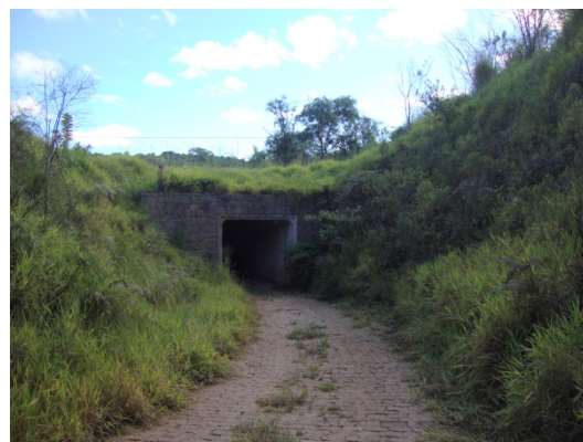
Foto 5.1.75 | Vista de talude de corte na Unidade G – Alta suscetibilidade aos escorregamentos induzidos. O talude apresenta altura de cerca de 6 metros, inclinação alta, e não apresenta nenhuma feição de instabilidade. Visada de oeste para leste. Ponto PC-47. Coordenadas 317.242 E e 7.440.395 N.
