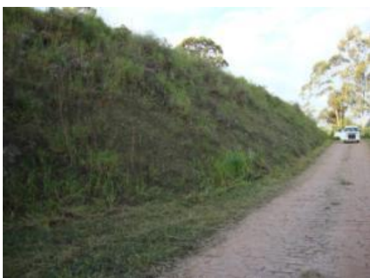
Foto 5.1.16 | Vista geral talude de corte com cerca de 7 metros de altura, apresentando perfil de solo bem desenvolvido, sem vestígio de rocha alterada. Porção sudoeste da ADA. Ponto PC-35. Coordenadas 317.101 E e 7.438.713 N.
