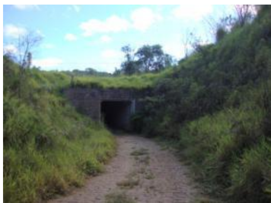
Foto 5.1.18 | Vista geral talude de corte com cerca de 7 metros de altura, apresentando perfil de solo bem desenvolvido, sem vestígio de rocha alterada. Porção central da ADA. Observa-se passagem inferior sob a estrada municipal. Ponto PC-47. Coordenadas 317.242 E e 7.440.395 N.
