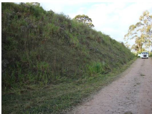
Foto 5.1.74 | Vista de talude de corte na Unidade G – Alta suscetibilidade aos escorregamentos induzidos. O talude apresenta altura de cerca de 5 metros, inclinação alta, e não apresenta nenhuma feição de instabilidade. Visada de oeste para leste. Ponto PC-35. Coordenadas 317.101 E e 7.438.713 N.
