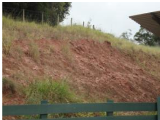
Foto 5.1.12 | Vista geral de talude de corte na AID, com a presença de gnaiss muito alterado. Ponto PC-11. Coordenadas 316.941E e 7.438.904 N.
