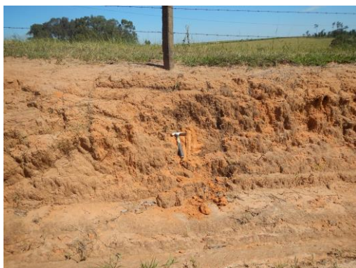
Vista geral de talude de corte com exposição de Argissolo Vermelho Amarelo (PVA26), na porção sudeste da AID. Visada de norte para sul. Ponto PC-14. Coordenadas 270.473 UTM E | 7.479.256 UTM S. Data 01/04/2021
