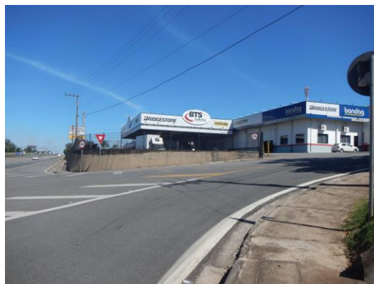
Vista geral da empresa Unicap, fora da envoltória de 500m. Visada de noroeste para sudeste. Ponto PC-22. Coordenadas 271.007 UTM E | 7.478.608 UTM S. Data 01/04/2021.
