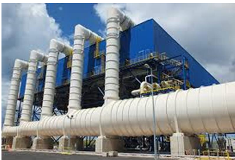
Figura 7.4.1.5-5 - Condensador a ar com duto de vapor de exaustão em primeiro plano.
