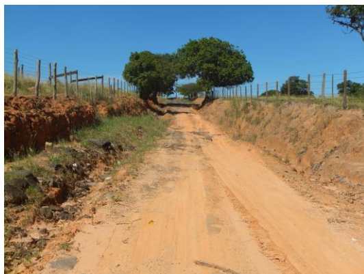
Vista geral de estrada de acesso com taludes de corte com exposição de Argissolo Vermelho Amarelo (PVA26), na porção sudeste da AID. Visada de oeste para leste. Ponto PC-37. Coordenadas 270.379 UTM E | 7.479.265 UTM S. Data 01/04/2021
