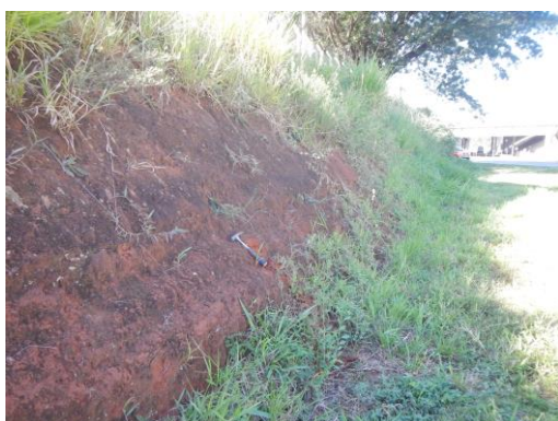
Vista geral de talude de corte com exposição de Latossolo Vermelho (LV27), na porção norte da AID. Visada de sudoeste para nordeste. Ponto PC-36. Coordenadas 268.780 UTM E | 7.481.120 UTM S. Data 01/04/2021
