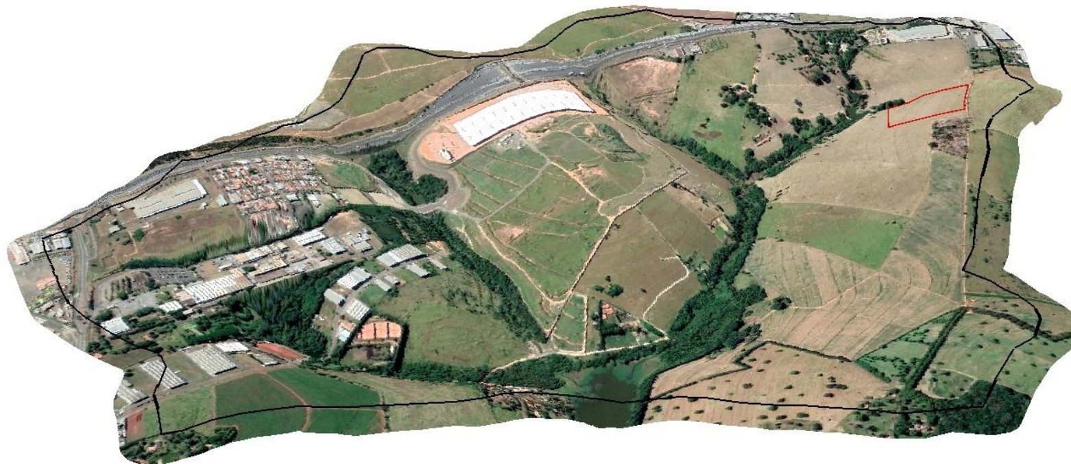
Figura 9.1.5.4-2 - Vista panorâmica da Área de Influência Direta (Sentido de oeste para leste).
