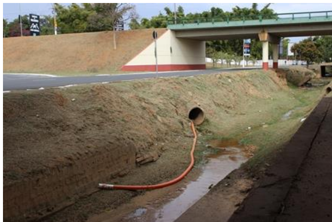
Figura 4.8. Córrego Invernada - captação emergencial. Fonte: DAEV, 2015.
