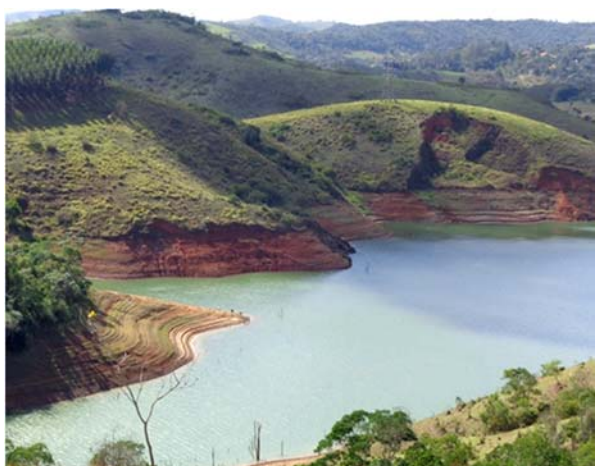
Cicatriz de grande deslizamento e erosões em encosta marginal do reservatório Jaguari, resultantes da descida abrupta do nível da água do reservatório e lençol freático.
