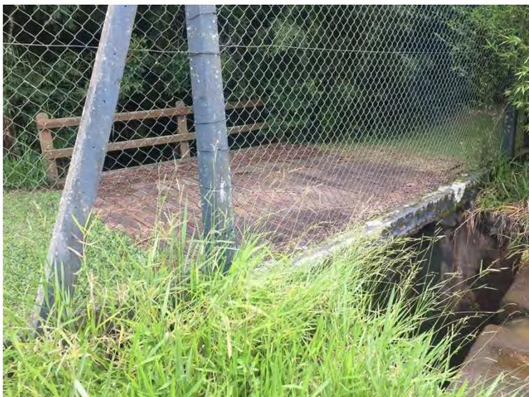
**Foto 5.** Detalhe do dispositivo hidráulico existente no barramento BA-02, neste barramento está previsto o alteamento de 0,50m da crista e o rebaixamento de 1,00m do nível normal de água.
