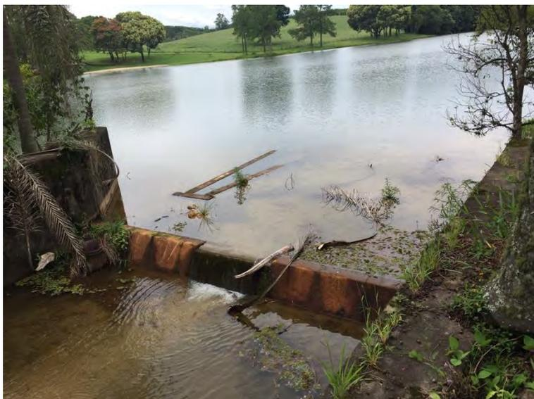
**Foto 14.** Vista do vertedor de parede delgada existente do barramento BA-05.
