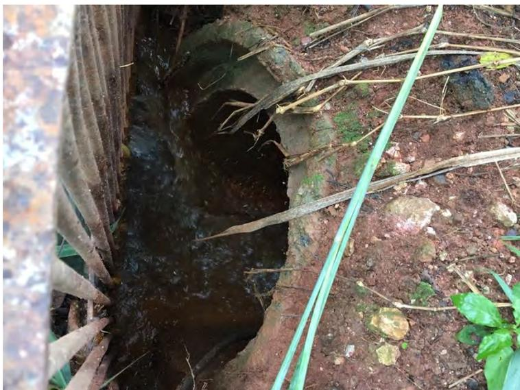
**Foto 11.** Detalhe do dispositivo hidráulico existente no barramento BA-04, este terá que ser readequado.
