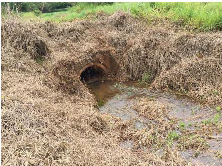
**Foto 8.** Detalhe do dispositivo hidráulico existente no barramento BA-03, este dispositivo terá que ser readequado para passagem da onda de cheia.
