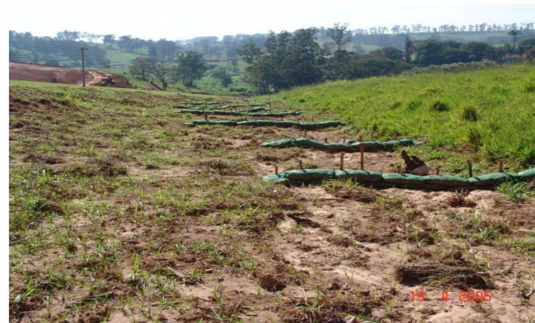
Barreiras físicas por meio de uso de sacos com terra vegetal nos talvegues.
