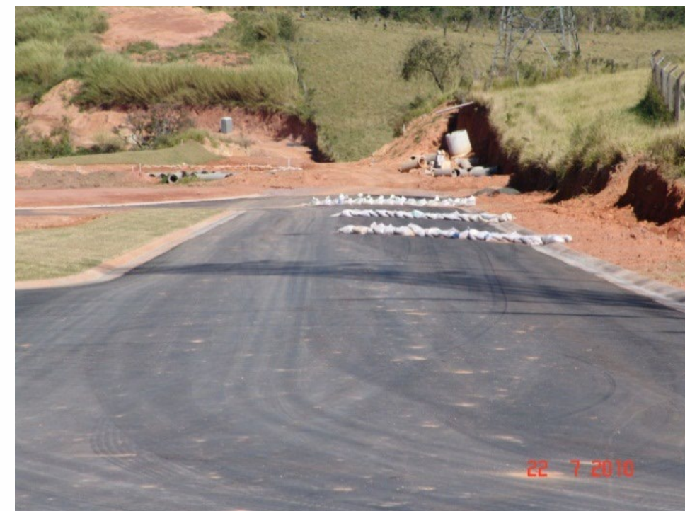
Barreiras físicas por meio de uso de sacos com brita.
