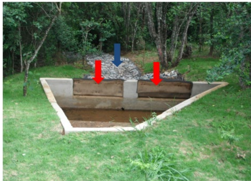
Modelo de dispositivo definitivo de drenagem. A seta vermelha indica os protetores cobertos por bidin que podem ser substituídos sempre que necessário e ao fundo (seta azul) colchão reno.
