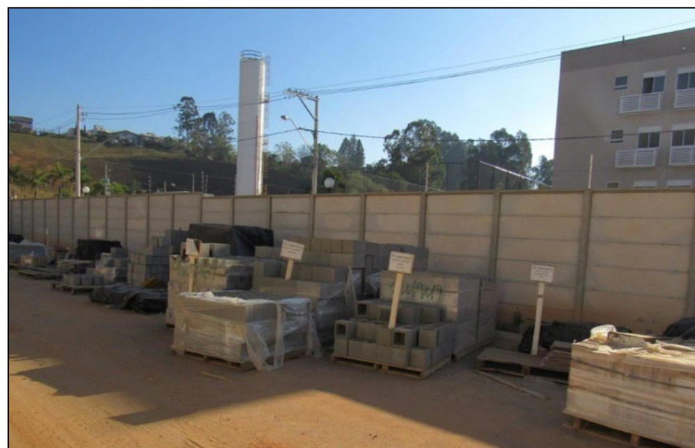
Organização de materiais com a devida identificação no canteiro de obras.
