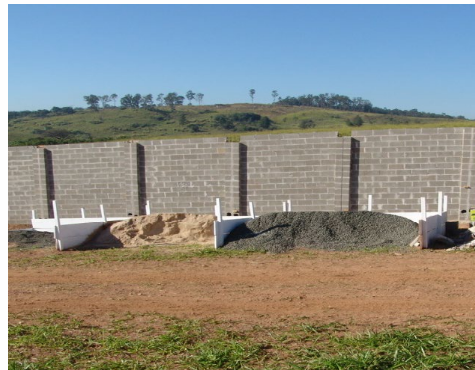
Baias itinerantes para deposição temporária de diferentes materiais da construção civil que estão sendo utilizados para a construção do muro.
