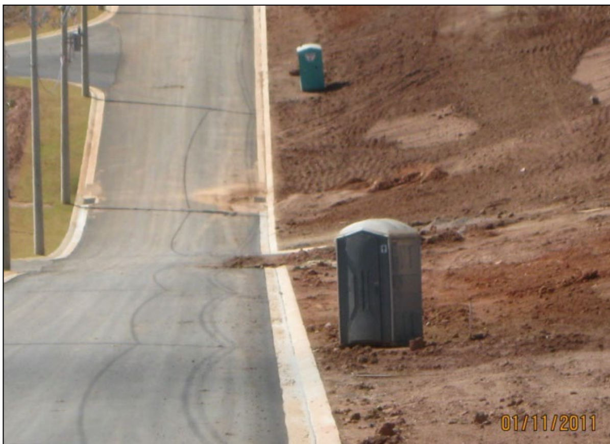
Utilização de banheiros químicos nas diversas frentes de trabalho.
