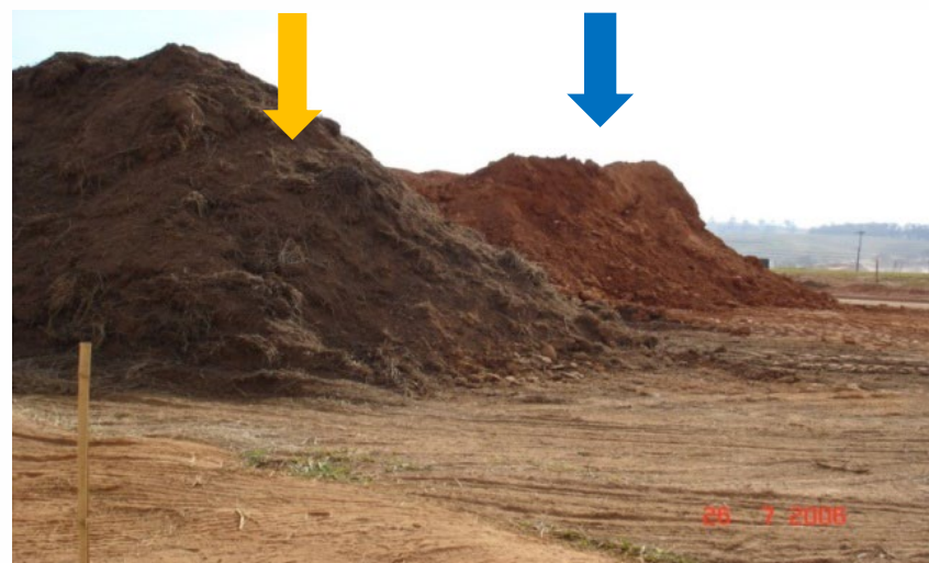
A seta amarela indica o armazenamento temporário de topsoil que será utilizado para agilizar o recobrimento vegetativo das áreas expostas e a seta azul indica demais horizontes de solo.
