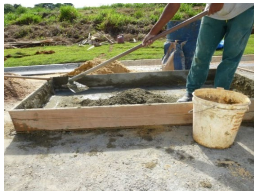
Vista da masseira que evita a dispersão de concreto e demais agregados no local da obra.
