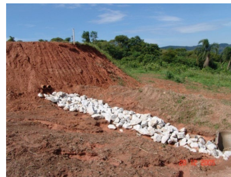
Estrutura de drenagem provisória por meio de rachões.
