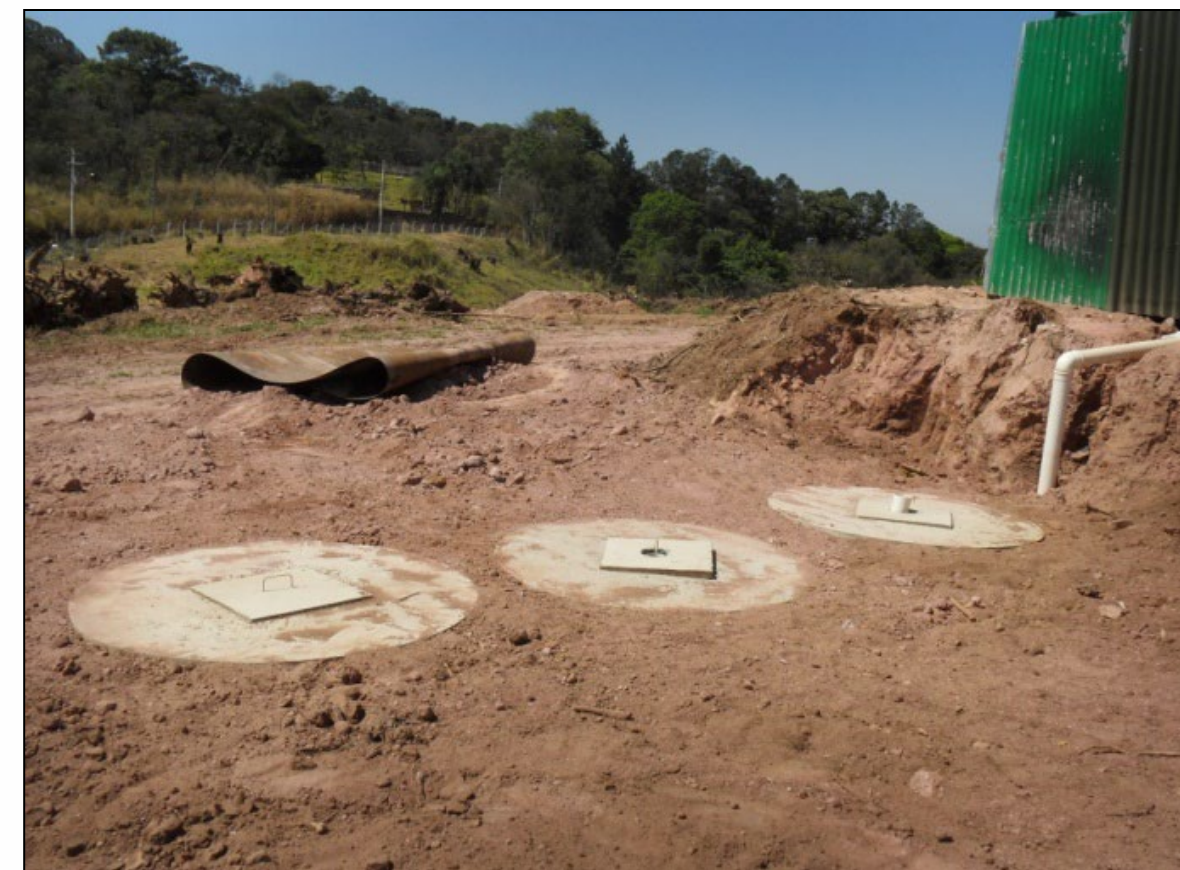
Utilização de fossas sépticas de acordo com as NBRs nº7229/93 e 13.969/97-ABNT, no canteiro de obras.
