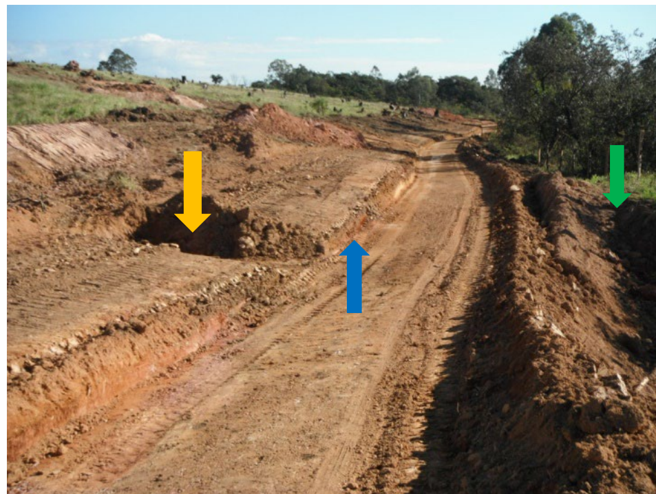
Tipos de estruturas de drenagem provisória: bacia de contenção (seta amarela), condução de fluxo de água pluvial em direção à bacia (seta azul) e murundum (seta verde) .
