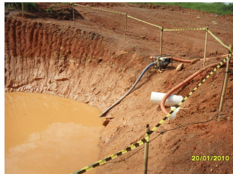
Construção de bacias temporárias de contenção onde uma bomba permite o esgotamento da água pluvial, sendo esta prática utilizada para manter a capacidade de armazenamento para a próxima chuva.
